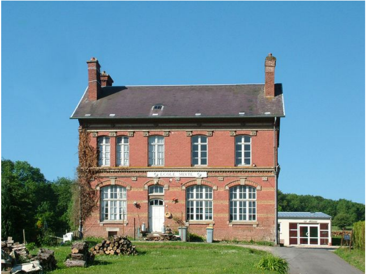
Façade du bâtiment principal.
