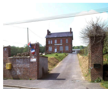
Vue générale depuis la rue. Phot. Marie-Laure Monnehay-Vulliet IVR22_20108000152XA
