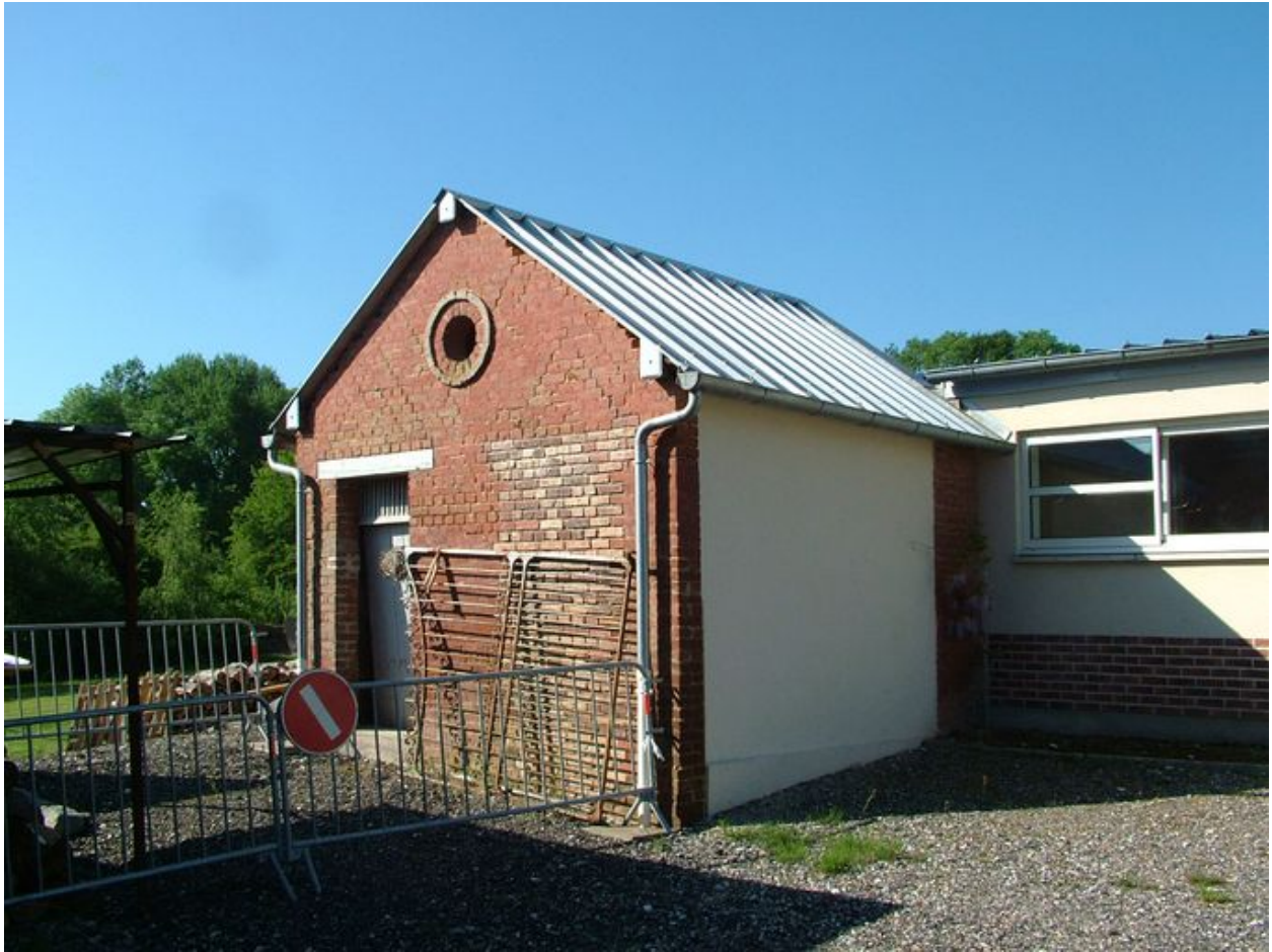
Ancien bâtiment annexe.
