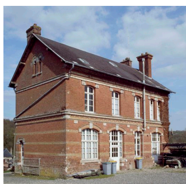
Vue de trois-quarts, depuis le nord- est, l'ancien accès à la salle de classe est visible dans le pignon. Phot. Marie-Laure Monnehay-Vulliet IVR22_20108000130XA
