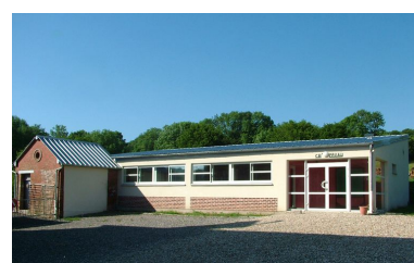
Salle communale moderne construite en prolongement d'un ancien bâtiment annexe. Phot. Frédéric Fournis IVR22_20108001799NUCA
