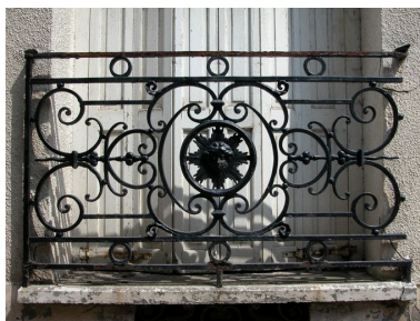
Détail de la ferronnerie du rez-de-chaussée. Phot. Elisabeth Justome IVR22_20048001559NUCA
