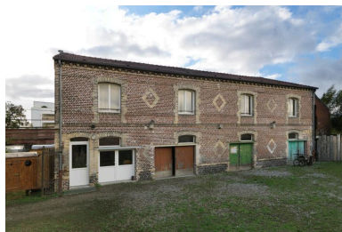
Ancienne scierie Delaplace : anciens logements ouvriers, devenus garage puis salle de spectacle et magasins de décor Phot. Thierry Lefébure IVR32_20206000181NUC2A
