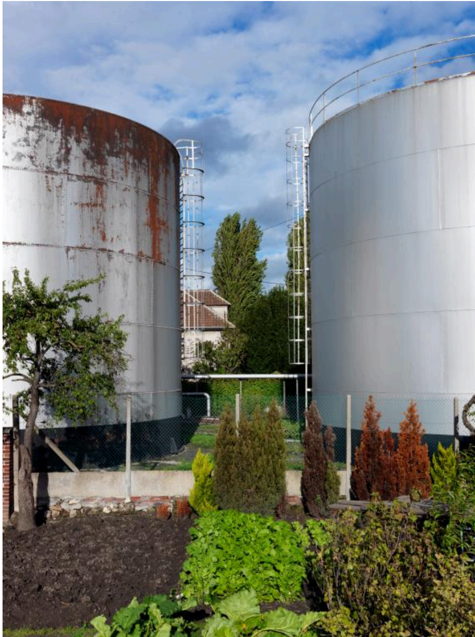
Ancienne scierie Delaplace, puis entrepôts de mélasse Fina : échelle de visite des cuves à mélasse de betteraves vue depuis le sud
