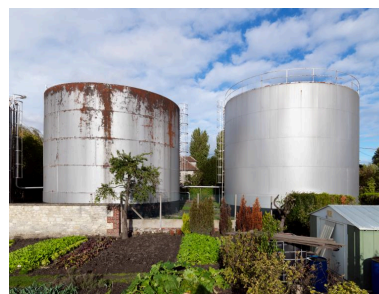
Ancienne scierie Delaplace, puis entrepôts de mélasse Fina : cuves à mélasse de betteraves avec les échelles de visite vue depuis le sud, potager sur l'emprise d'une rue de logements ouvriers détruits Phot. Thierry Lefébure IVR32_20206000186NUC2A
