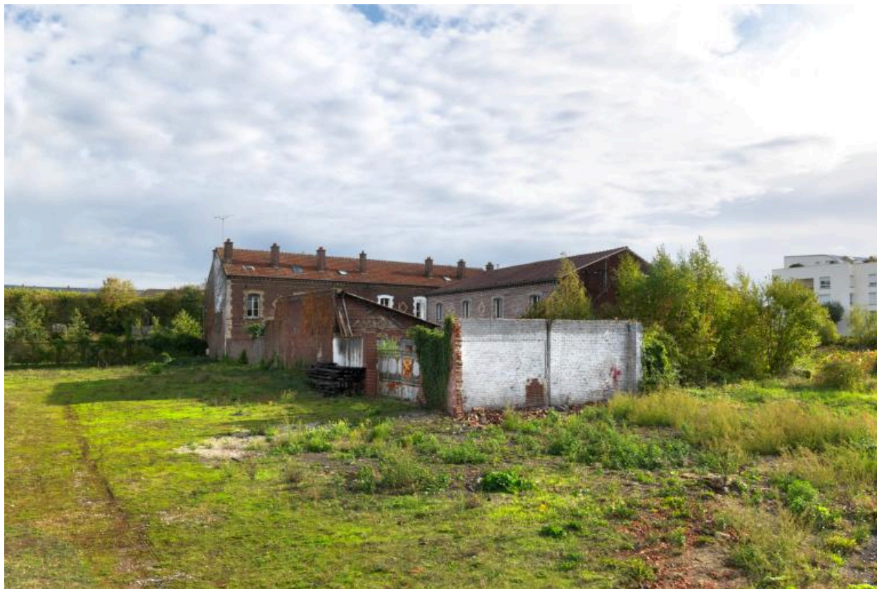
Ancienne scierie Delaplace : vue de l'enclos actuel des bâtiments restants depuis le nord-ouest du site
