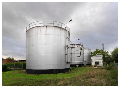
Ancienne scierie Delaplace, puis entrepôts de mélasse Fina : cuves à mélasse de betteraves, conduites pour les chargement des péniches et poste de pompage vus depuis l'est Phot. Thierry Lefébure IVR32_20206000188NUC2A
