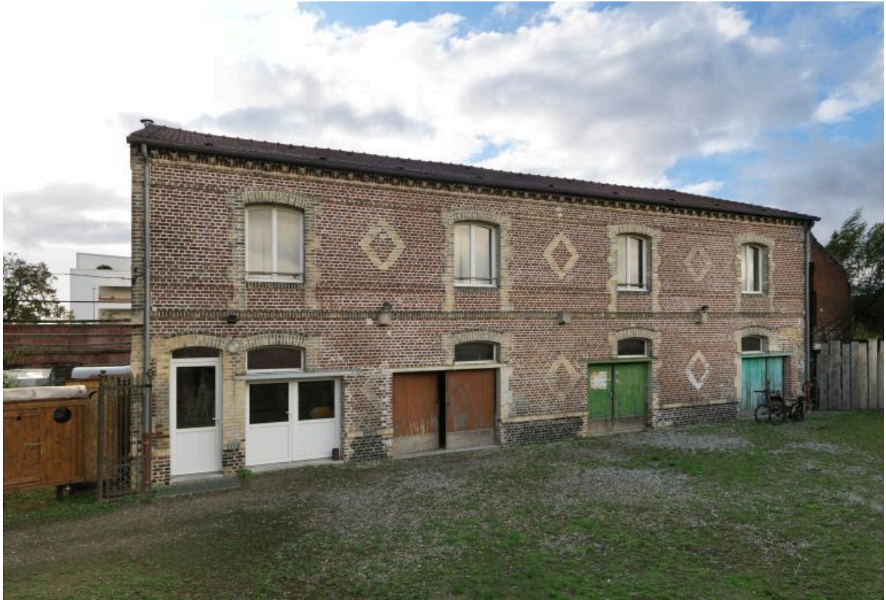
Ancienne scierie Delaplace : anciens logements ouvriers, devenus garage puis salle de spectacle et magasins de décor
