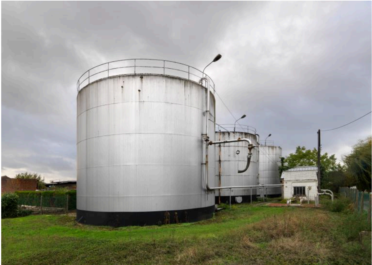
Ancienne scierie Delaplace, puis entrepôts de mélasse Fina : cuves à mélasse de betteraves, conduites pour les chargement des péniches et poste de pompage vus depuis l'est
