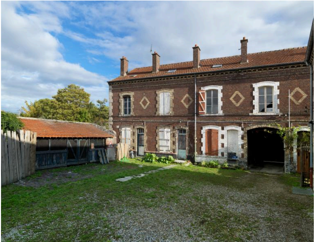
Ancienne scierie Delaplace, fabrique Moores and Cie et logements de cheminot : bûcher ou buanderie, emplacement du poulailler, partie nord des logements de la maison fermant la cour sur le chemine de halage, vus depuis l'ancien emplacement des toilettes
