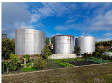
Ancienne scierie Delaplace, puis usine de transformation de charbons André Lerouge, puis Lesaffre, et entrepôts de mélasse Fina : cuves à mélasse de betteraves vues depuis le sud Phot. Thierry Lefébure IVR32_20206000185NUC2AQ
