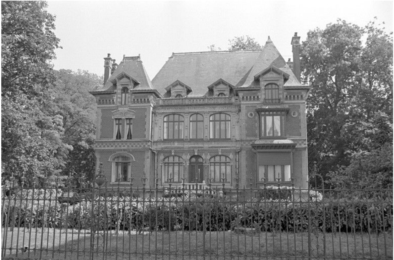
Second logement patronal dit "château Buiret", élévation antérieure, en 1989.
