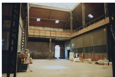
Ancien atelier de fabrication, en 1990. Phot. Thierry Lefébure IVR22_20158000835NUC2A
