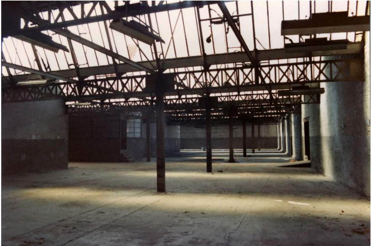
Anciens ateliers de fabrication, en 1990.
