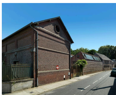
Vue des ateliers de fabrication depuis la rue Jean-Catelas. Phot. Thierry Lefébure IVR22_20148000435NUC2A
