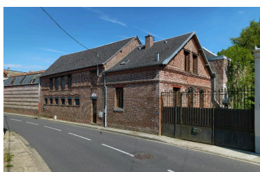
Vue des anciens bureaux et des anciens ateliers de fabrication depuis la rue Jean-Catelas. Phot. Thierry Lefébure IVR22_20148000436NUC2A
