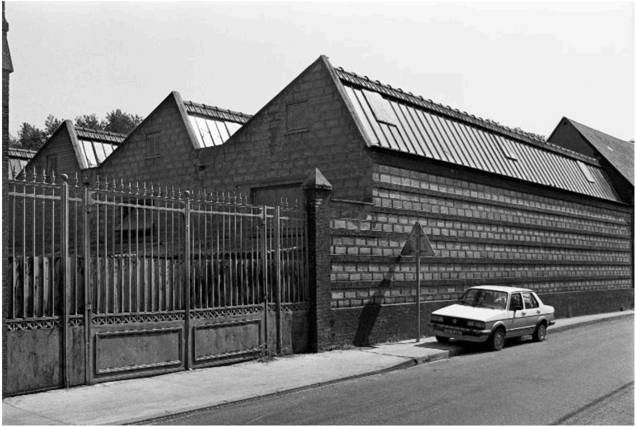
Atelier de fabrication, élévation antérieure, en 1990.
