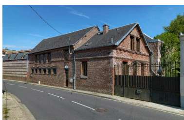
Vue des anciens bureaux et des anciens ateliers de fabrication depuis la rue Jean-Catelas. Phot. Thierry Lefébure IVR22_20148000436NUC2A
