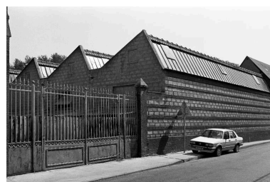
Atelier de fabrication, élévation antérieure, en 1990. Phot. Francis Dubuc IVR22_19908000440Z
