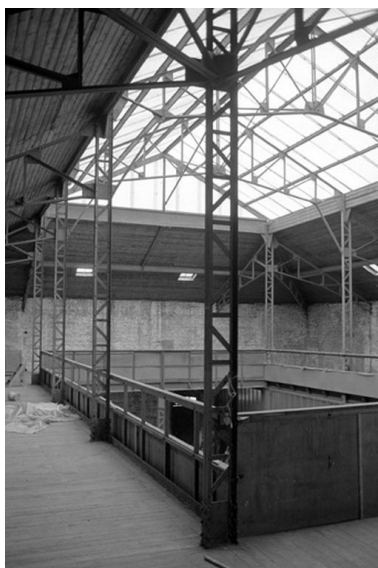
Atelier de fabrication de l'usine Buiret-Debeaurain, vue intérieure, en 1989. Phot. Francis Dubuc IVR22_19908000846Z
