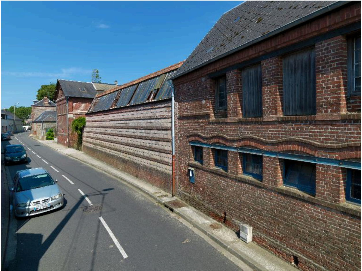
Vue des anciens ateliers de fabrication depuis la rue Jean-Catelas.
