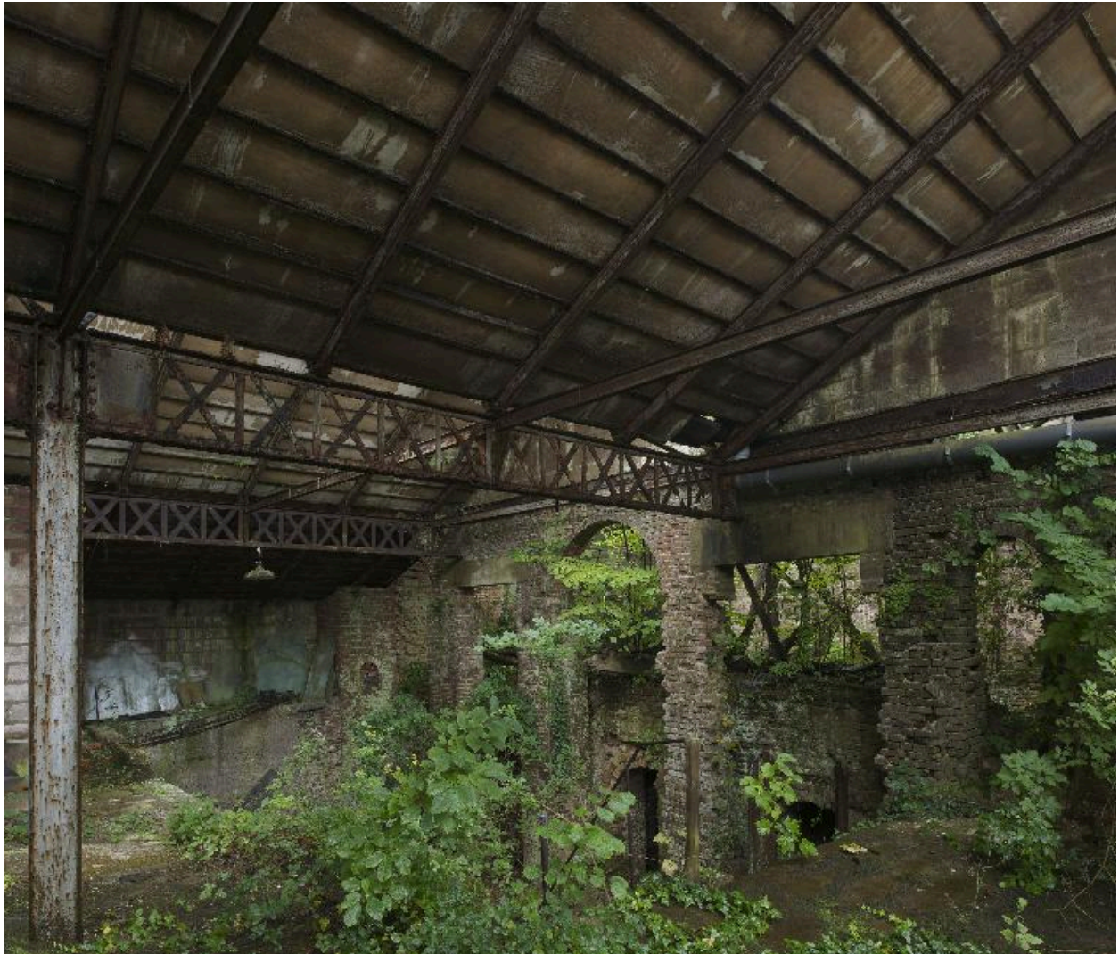
Vue de trois-quarts des anciens fours.
