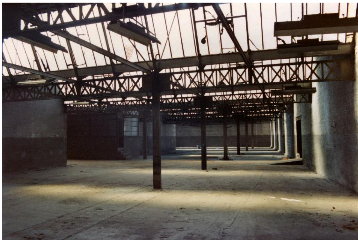
Anciens ateliers de fabrication, en 1990.
