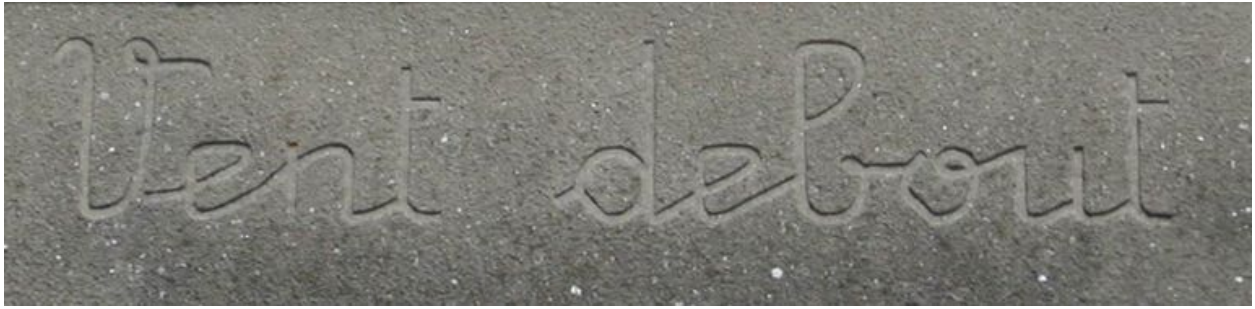
Détail de l'appellation gravée sur le mur.
