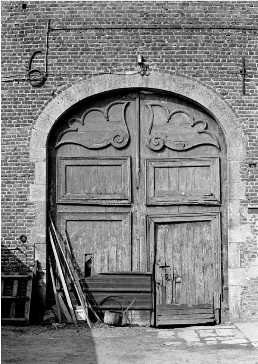
Détail d'une des trois portes charretières de la grange.
