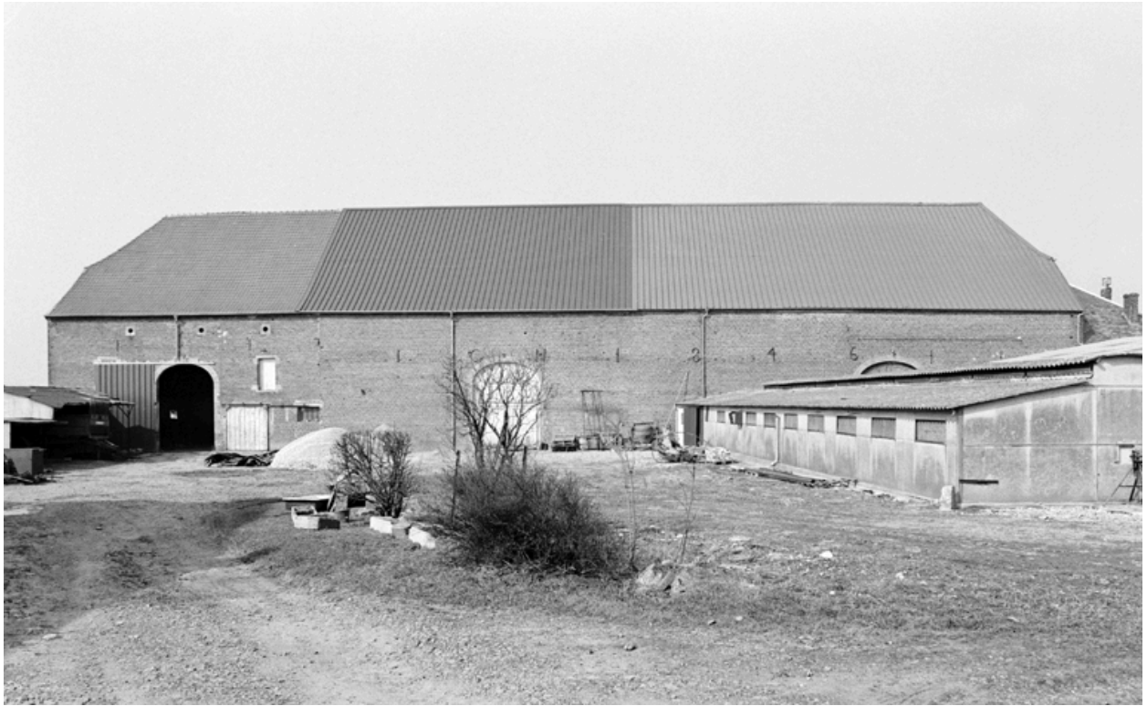
Façade de la grange.
