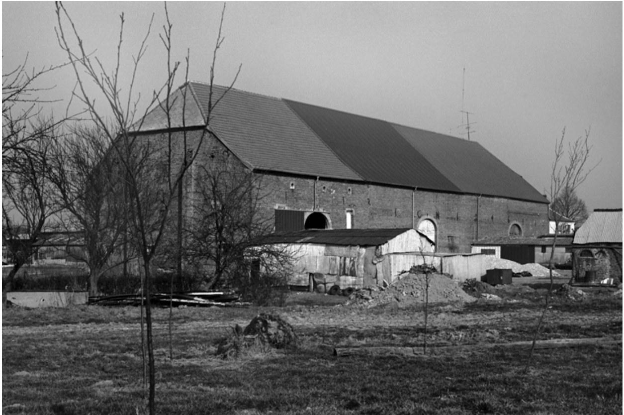
Vue générale sud de la grange.
