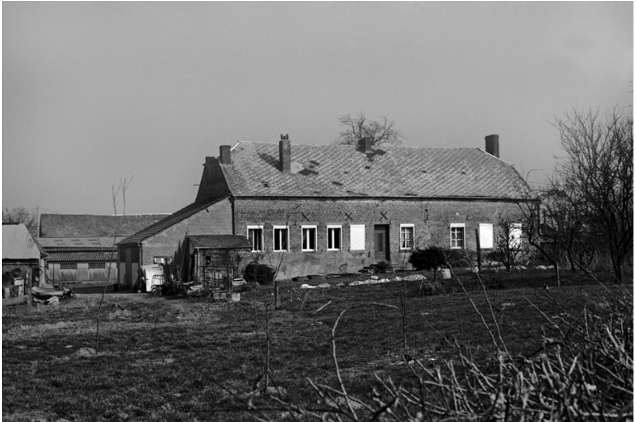
Façade du logis.
