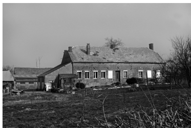
Façade du logis. Phot. Christiane Riboulleau IVR22_19960200389Z
