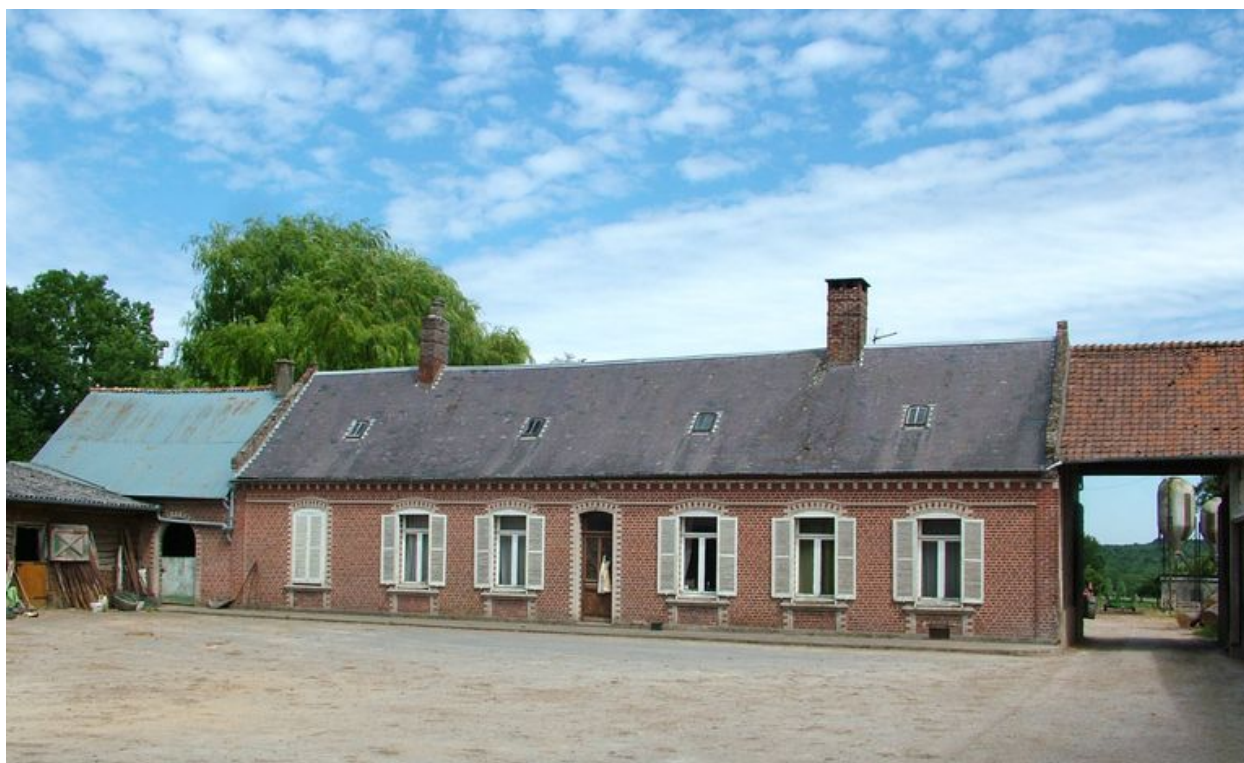
Logis de ferme, 10 Grande-Rue, portant la date de 1792 mais reconstruit au milieu du 19e siècle.
