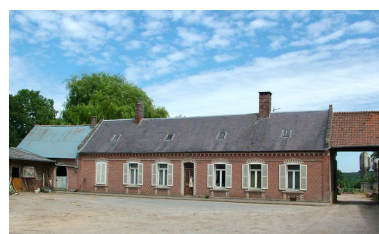
Logis de ferme, 10 Grande-Rue, portant la date de 1792 mais reconstruit au milieu du 19e siècle. Phot. Frédéric Fournis IVR22_20108001923NUCA
