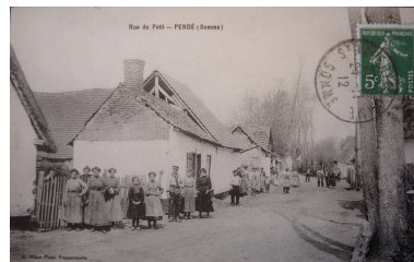
Vue de la rue du Petit-Pendé au début du 20e siècle. Phot. Inès Guérin IVR22_20078005010NUCAB
