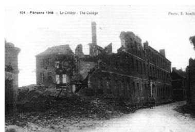
Le Collège en ruines, en 1918 (AD Somme ; 8 Fi 1774). Phot. Gilles-Henri Bailly (reproduction) IVR22_20158005699NUCA
