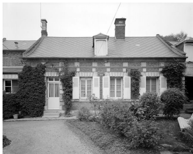
Logis. Vue générale. Phot. Jean-Michel Perrin IVR22_19846001228V
