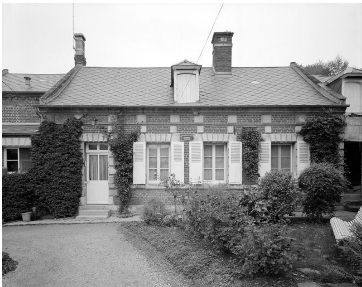
Logis. Vue générale.
