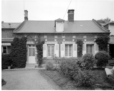
Logis. Vue générale. Phot. Jean-Michel Perrin IVR22_19846001228V
