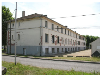
Barre de logements dans la cité ouvrière. Phot. Clarisse Lorieux IVR22_20096005093NUCA
