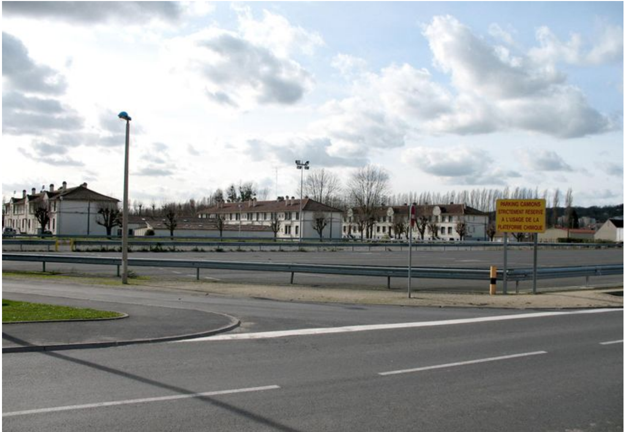
Les trois barres de logements ouvriers inaugurées en 1948.
