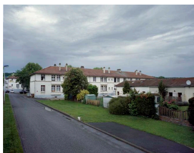
Vue générale de la cité construite en 1948.
