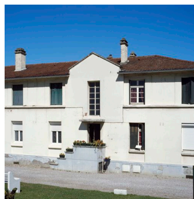
Entrée de l'une des barres. Phot. Thierry Lefébure IVR22_20106000629XA
