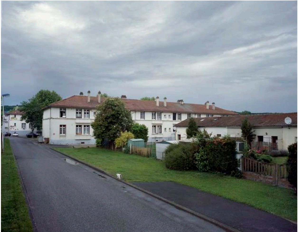
Vue générale de la cité construite en 1948.
