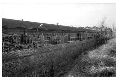
Atelier de fabrication (1), flanc est. Phot. Thierry Lefébure IVR22_19888000173Z
