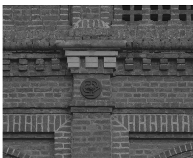
Atelier de fabrication (1), détail. Phot. Thierry Lefébure IVR22_19898000452X
