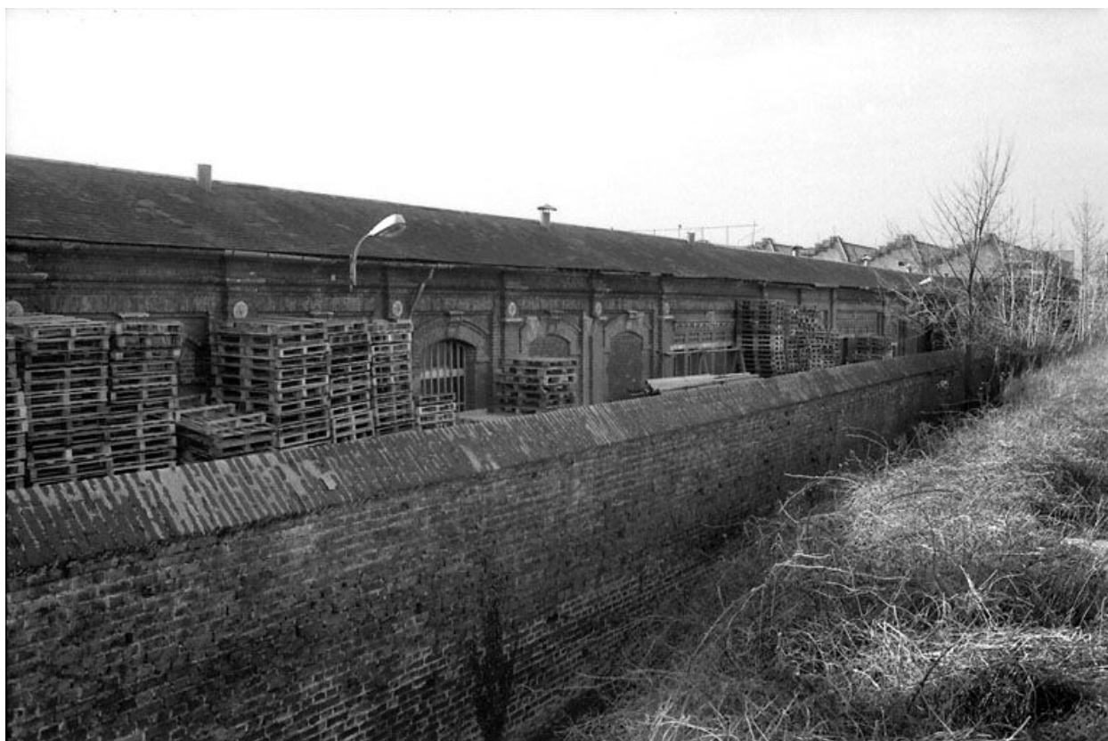
Atelier de fabrication (1), flanc est.
