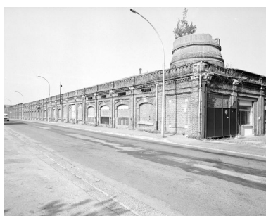
Atelier de fabrication, flanc sud. Phot. Thierry Lefébure IVR22_19898000375X
