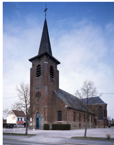
Vue générale depuis le sud-est. Phot. Pierre Thibaut IVR31_20095901342VA
