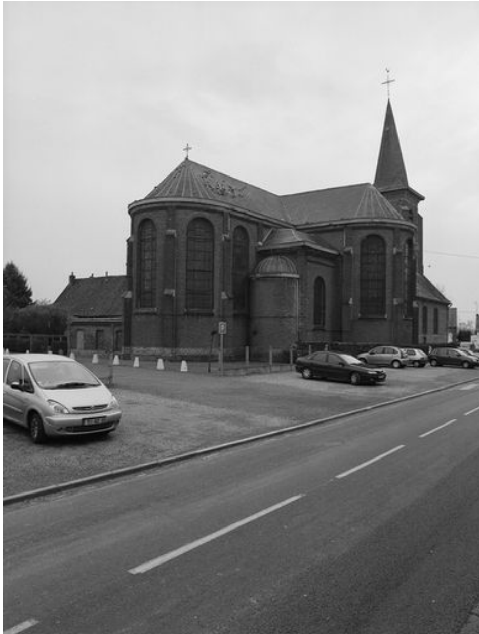
Vue générale du choeur, depuis le nord-ouest.
