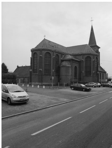
Vue générale du chœur, depuis le nord-ouest. Phot. Philippe Dapvril IVR31_20045900058X
