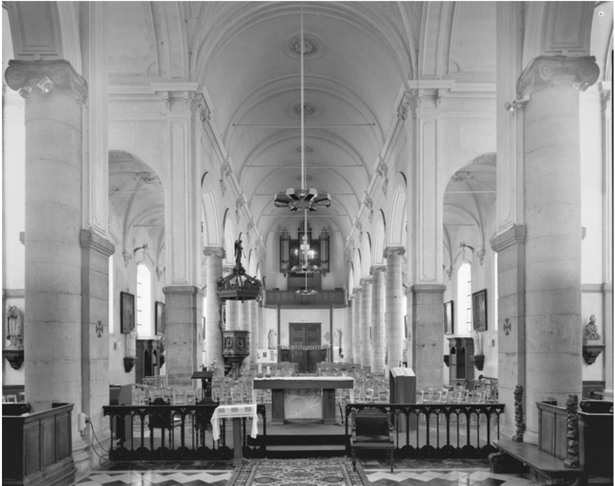
Vue générale intérieure, vers l'entrée.
