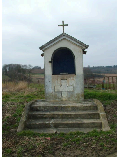
Vue de l'oratoire situé entre Craonnelle et Craonne. Phot. Inès Guérin IVR22_20050200566NUCA
