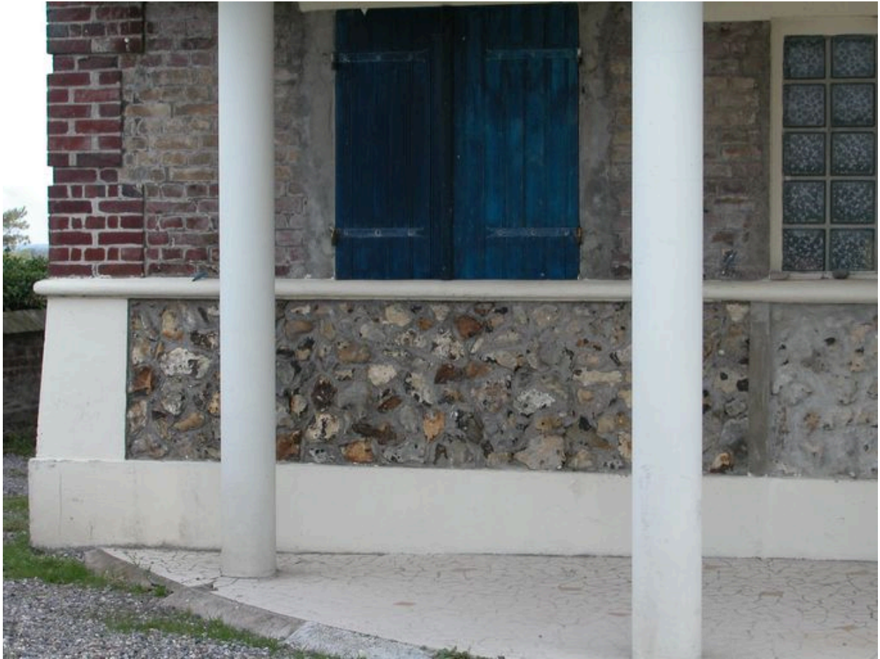
Détail de la mise en oeuvre du rez-de-chaussée (moellons de silex).
