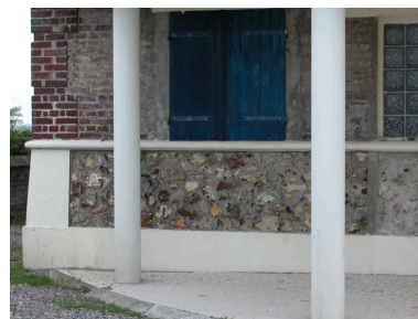
Détail de la mise en œuvre du rez-de-chaussée (moellons de silex). Phot. Elisabeth Justome IVR22_20058002644NUCA
