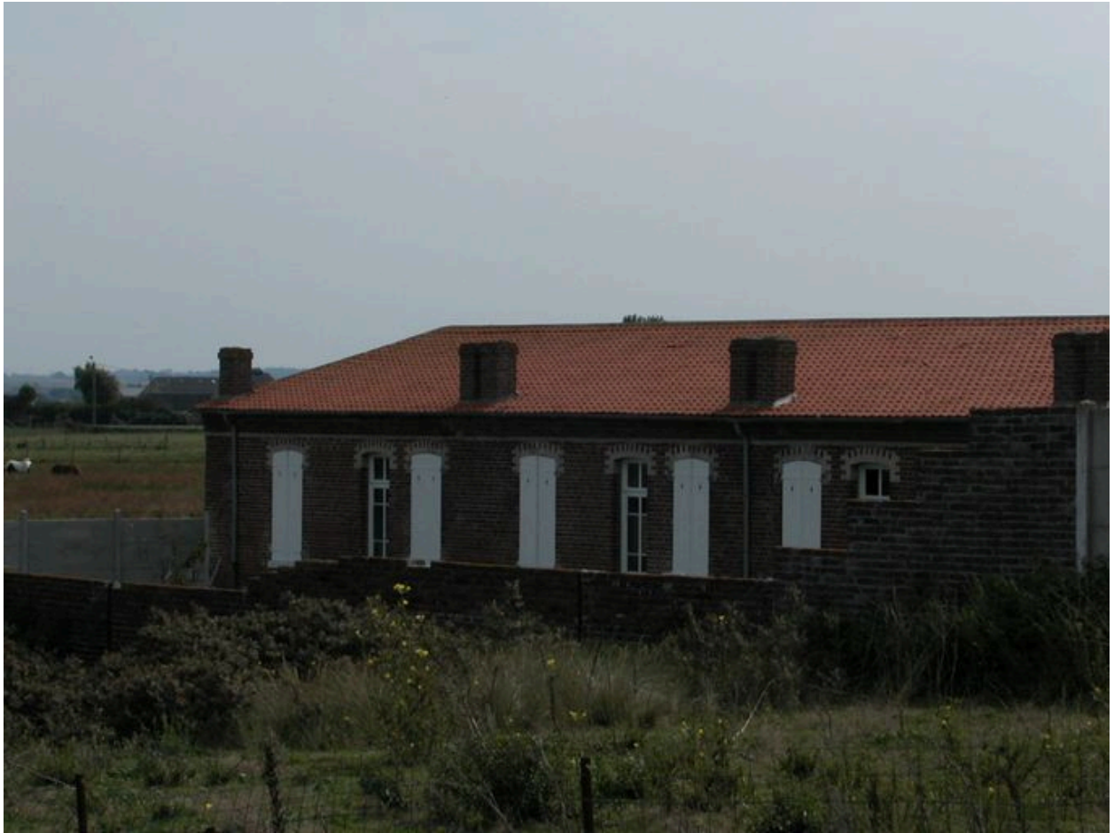
Vue des logements en fond de parcelle.
