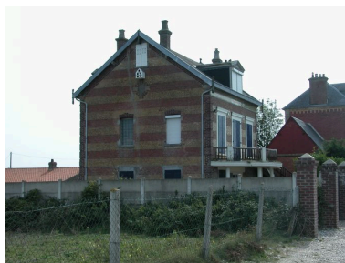
Élévation latérale gauche. Phot. Elisabeth Justome IVR22_20058002643NUCA
