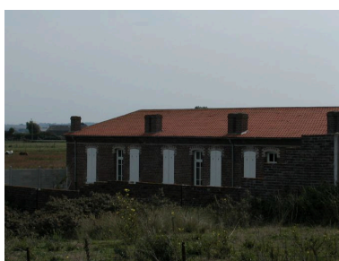
Vue des logements en fond de parcelle. Phot. Elisabeth Justome IVR22_20058002646NUCA
