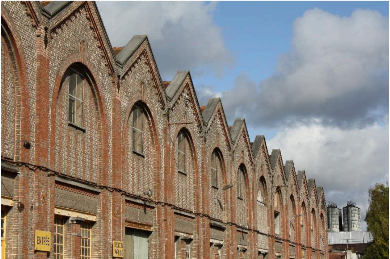
Vue d'ensemble de la façade est de la bâcherie.
