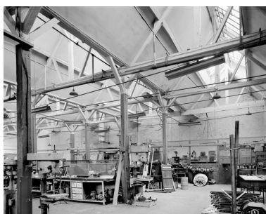
Atelier de réparation, en 1988 : vue intérieure. Phot. Thierry Lefébure IVR22_19888000691V
