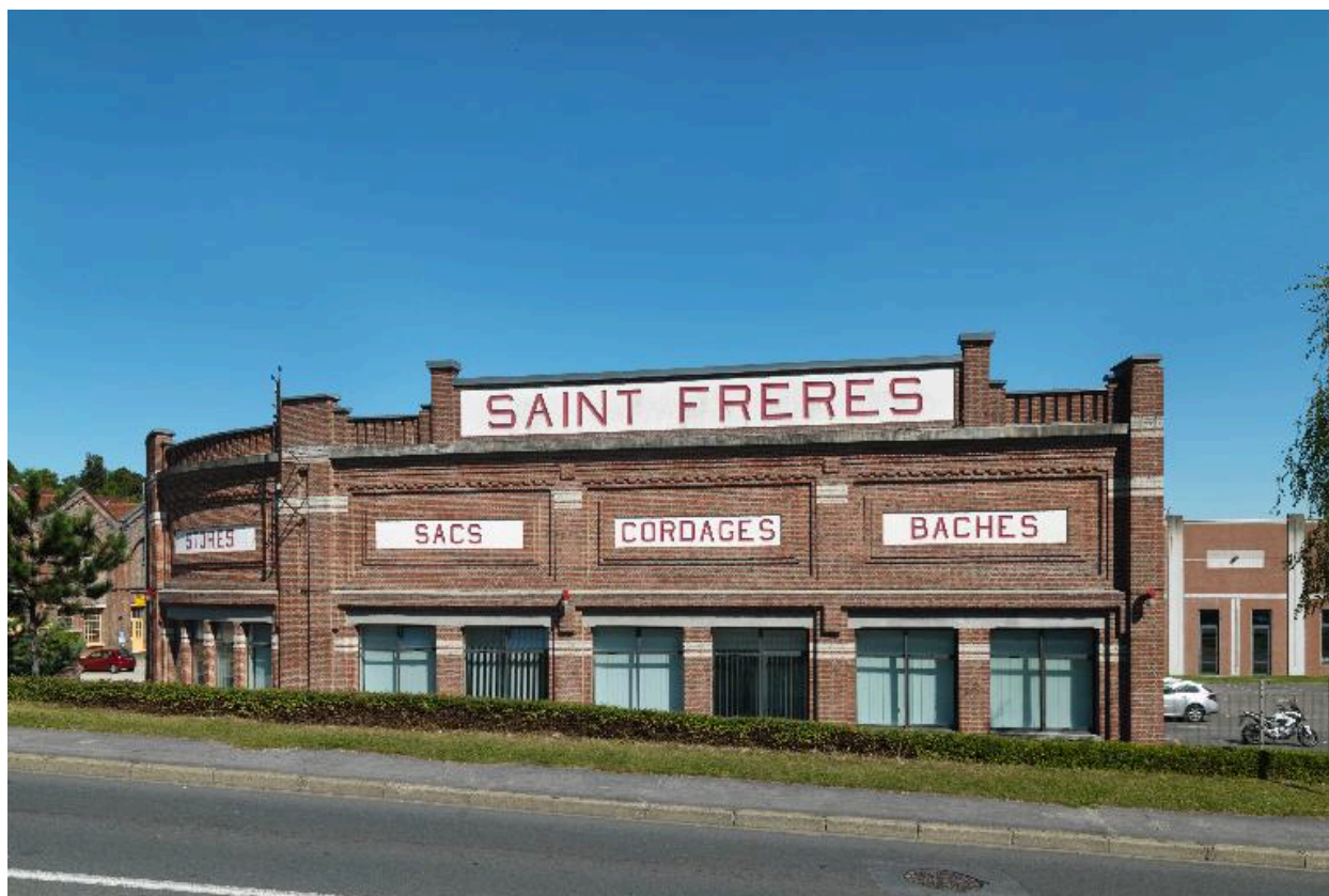
Façade sur rue de l'ancienne sacherie et magasins.
