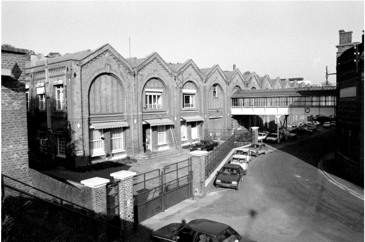
Façade sud de l'ancienne bâcherie en 1987.
