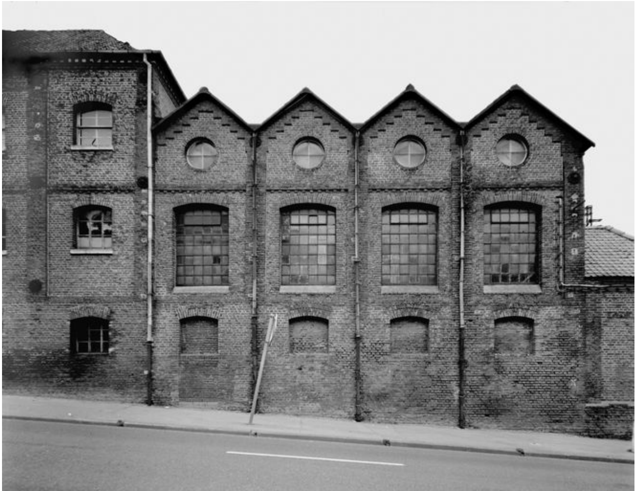
Façade sur rue de l'ancienne chaufferie. Etat en 1988.
