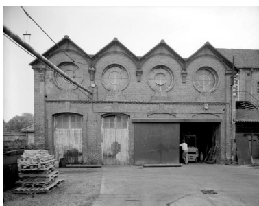
Façade sur cour de l'ancienne chaufferie. Etat en 1988. Phot. Thierry Lefébure IVR22_19888000663V
