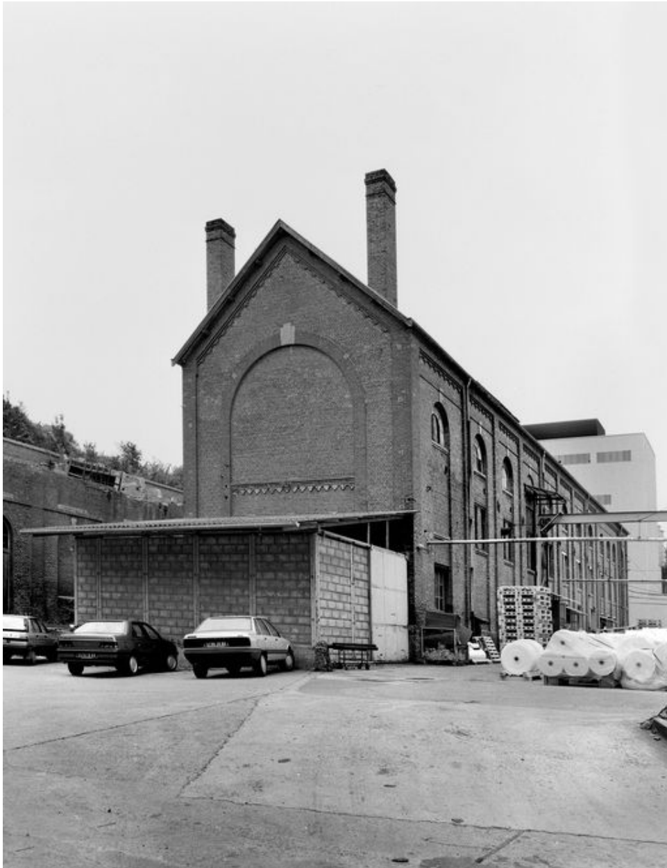
Bâtiment non identifié, en 1988.
