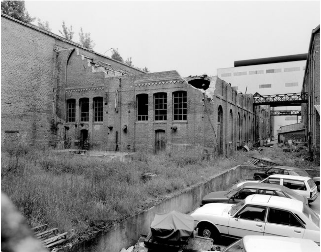
Bâtiment à l'arrière de la bâcherie, état en 1988.
