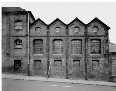
Façade sur rue de l'ancienne chaufferie. Etat en 1988. Phot. Thierry Lefébure IVR22_19888000669V
