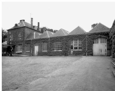
Tissage de jute. Vue d'ensemble sur cour de la conciergerie et de l'atelier de réparation attenant. Etat en 1988. Phot. Thierry Lefébure IVR22_19888000668V
