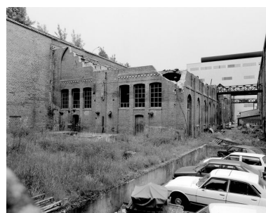
Bâtiment à l'arrière de la bûcherie, état en 1988. Phot. Thierry Lefébure IVR22_19888000676V
