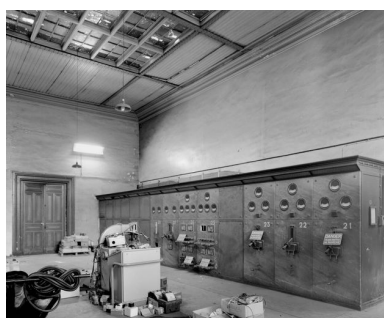
Intérieur de l'ancienne salle des machines, devenue centrale électrique. Etat en 1988. Phot. Thierry Lefébure IVR22_19888000687V
