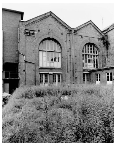
Pignons latéraux de l'ancienne bûcherie. Etat en 1988. Phot. Thierry Lefébure IVR22_19888000675V
