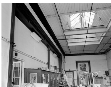
Vue intérieure de l'ancienne salle des machines. Etat en 1988. Phot. Thierry Lefébure IVR22_19888000689V
