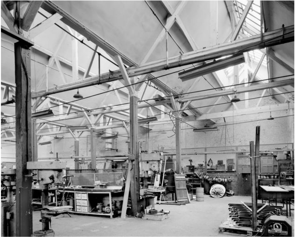
Atelier de réparation, en 1988 : vue intérieure.
