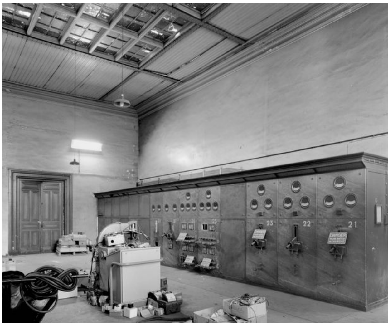
Intérieur de l'ancienne salle des machines, devenue centrale électrique. Etat en 1988.
