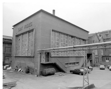
Chaufferie en 1988. Phot. Thierry Lefébure IVR22_19888000674X
