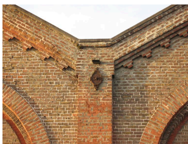
Façade de la bâtisserie, détail des fers d'ancrage marqués des initiales Saint Frères. Phot. Bertrand Fournier IVR22_20128005230NUCA
