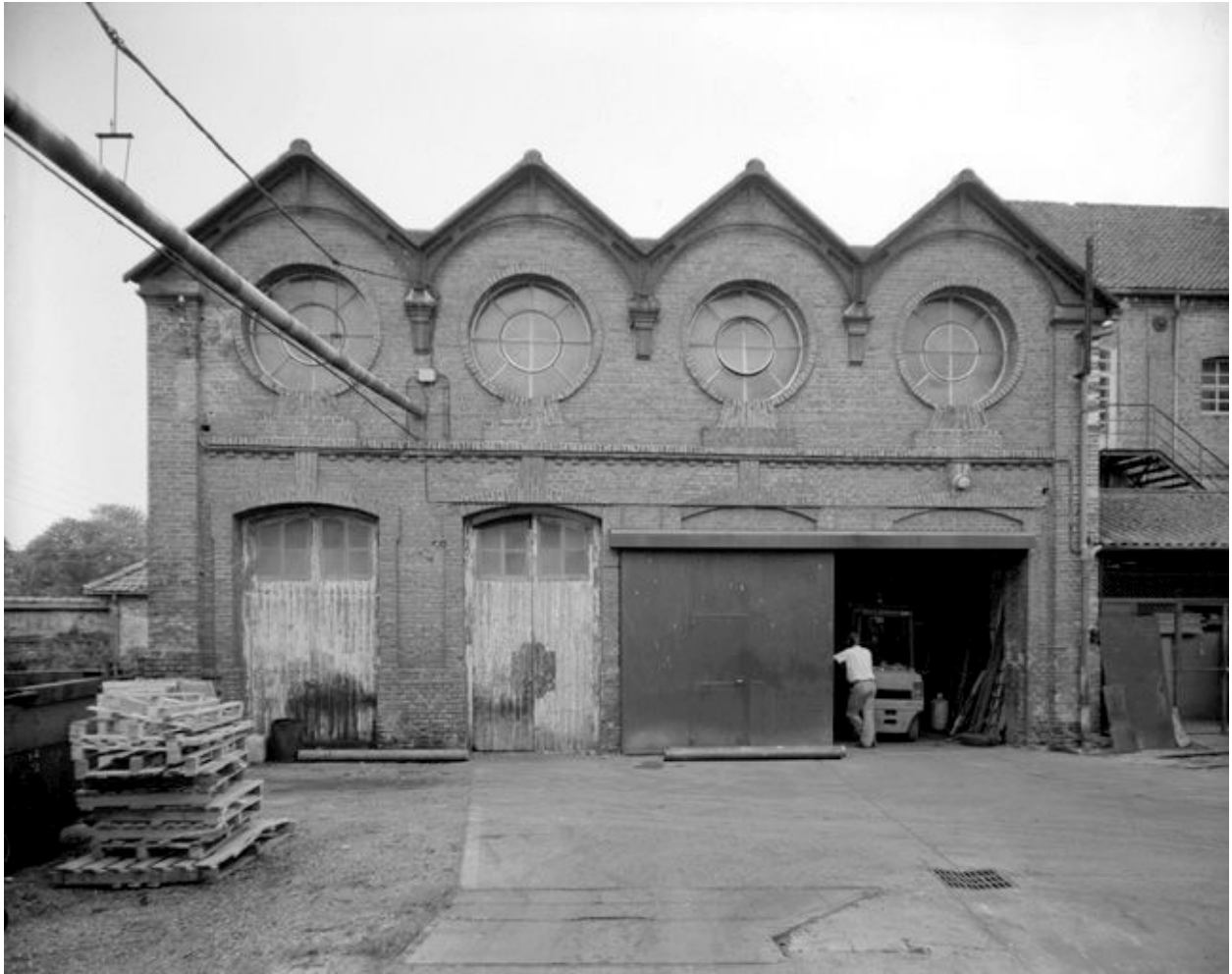
Façade sur cour de l'ancienne chaufferie. Etat en 1988.
