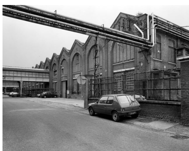
Façade sur rue de l'ancienne bûcherie, état en 1988. Phot. Thierry Lefébure IVR22_19888000672V
