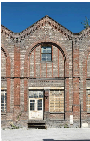
Détail d'une travée de la bâtisserie, façade est. Phot. Thierry Lefébure IVR22_2012800588NUC2A
