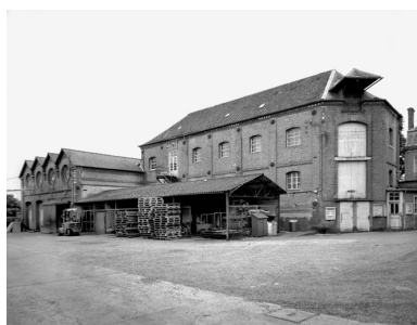
Façade sur cour d'un atelier de tissage et de l'ancienne chaufferie. Etat en 1988. Phot. Thierry Lefébure IVR22_19888000662V
