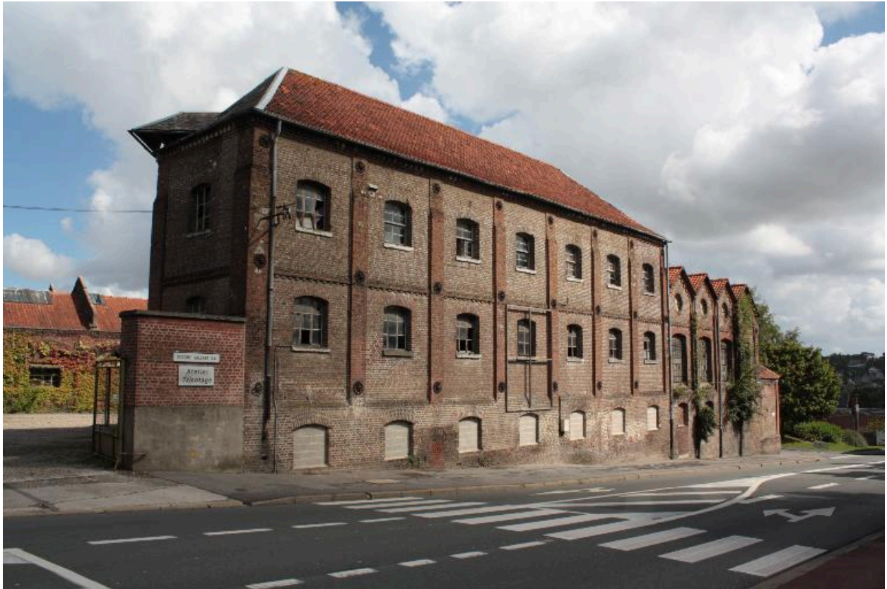
Façade sur rue du tissage de jute Saint Frères.
