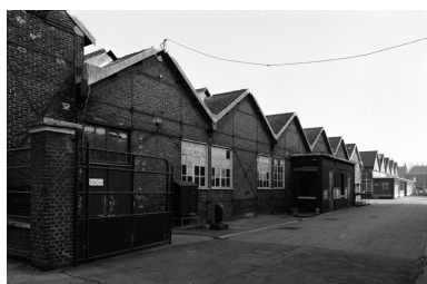
Vue partielle des ateliers de fabrication (ancien chemin de Ville-le-Marlet), en 1987 Phot. Benoît Dufournier IVR22_19878000398Z
