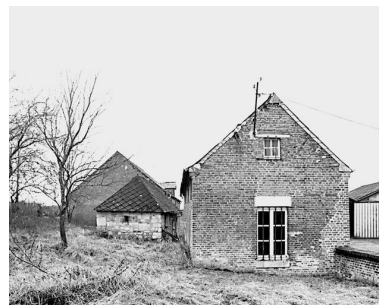
Logement agricole, petite dépendance et étable à l'arrière-plan. Phot. Xavier-Philippe Guiochon IVR22_19970202386Z
