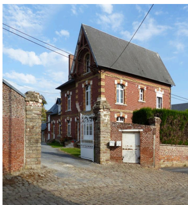
Athies. Ferme, rue du Pavé. Phot. Isabelle Barbedor IVR32_20188005119NUCA
