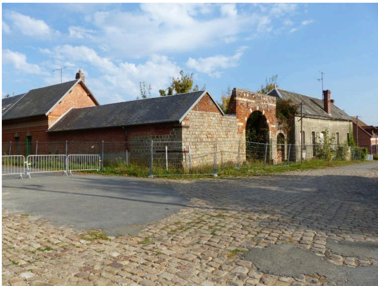
Athies. Rue du Pavé. La ferme, dite du Prieuré.
