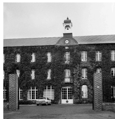
Atelier de fabrication principal, vue partielle, élévation antérieure, en 1990. Phot. Francis Dubuc IVR22_19908000487X
