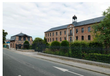
Vue d'ensemble de la conciergerie et des anciens ateliers de l'usine Laperche. Phot. Thierry Lefébure IVR22_20148000480NUC2A
