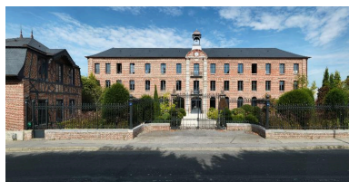
Vue des anciens ateliers de fabrication de l'usine Laperche, aujourd'hui Showroom de l'entreprise Delabie. Phot. Thierry Lefébure IVR22_20148000477NUC2AQ
