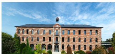
Anciens ateliers de fabrication, aujourd'hui showroom de l'entreprise Delabie. Phot. Thierry Lefébure IVR22_20148000475NUC2AQ
