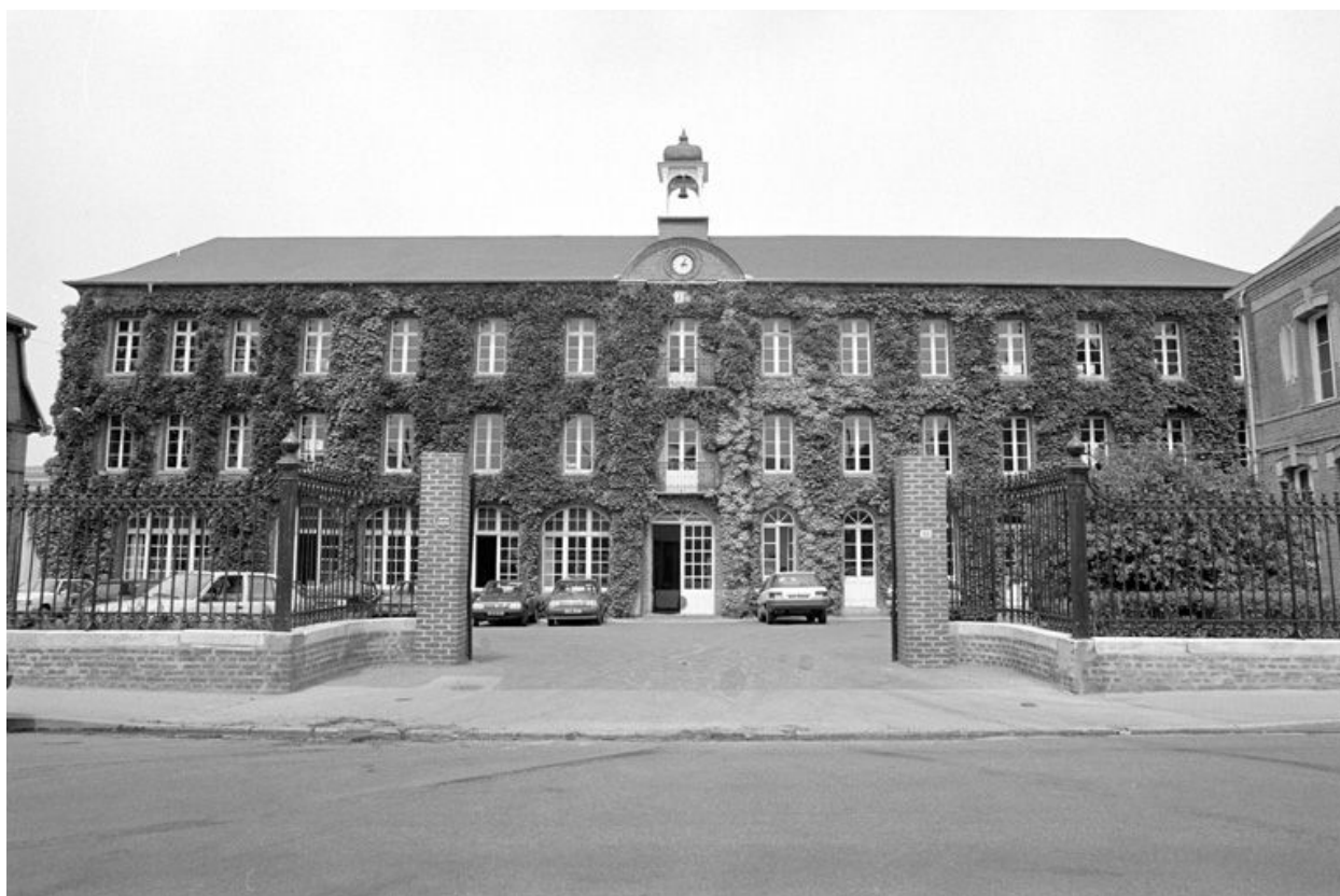
Atelier de fabrication principal, élévation antérieure, en 1990.
