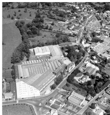
Vue aérienne, flanc ouest, en 1988. Phot. Phot'R IVR22_19888001443P
