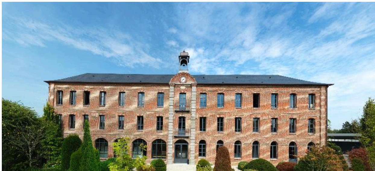
Anciens ateliers de fabrication, aujourd'hui showroom de l'entreprise Delabie.
