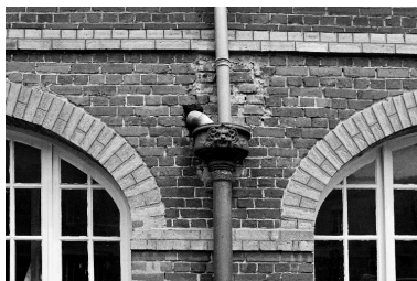
Atelier de fabrication, sud-est, détail, en 1990. Phot. Francis Dubuc IVR22_19908000285Z
