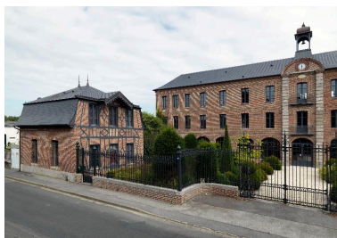
Vue d'ensemble de la conciergerie et des anciens ateliers de l'usine Laperche. Phot. Thierry Lefébure IVR22_20148000479NUC2A
