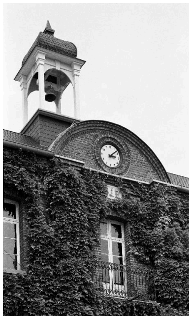
Atelier de fabrication, principal, détail, en 1990. Phot. Francis Dubuc IVR22_19908000296Z
