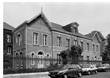
Bureau, élévation antérieure, en 1990. Phot. Francis Dubuc IVR22_19908000292Z
