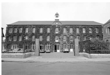
Atelier de fabrication principal, élévation antérieure, en 1990. Phot. Francis Dubuc IVR22_19908000291Z
