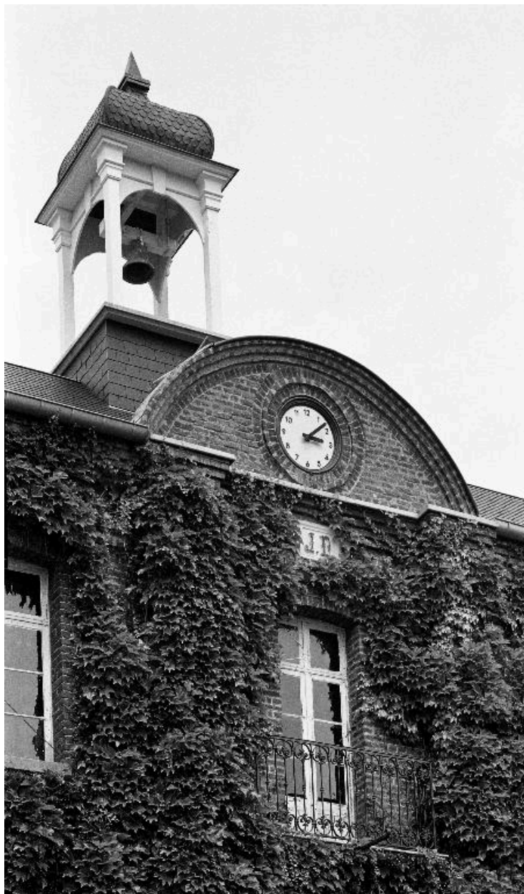
Atelier de fabrication, principal, détail, en 1990.
