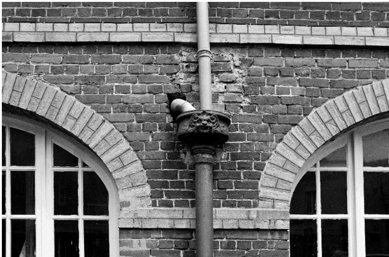
Atelier de fabrication, sud-est, détail, en 1990.
