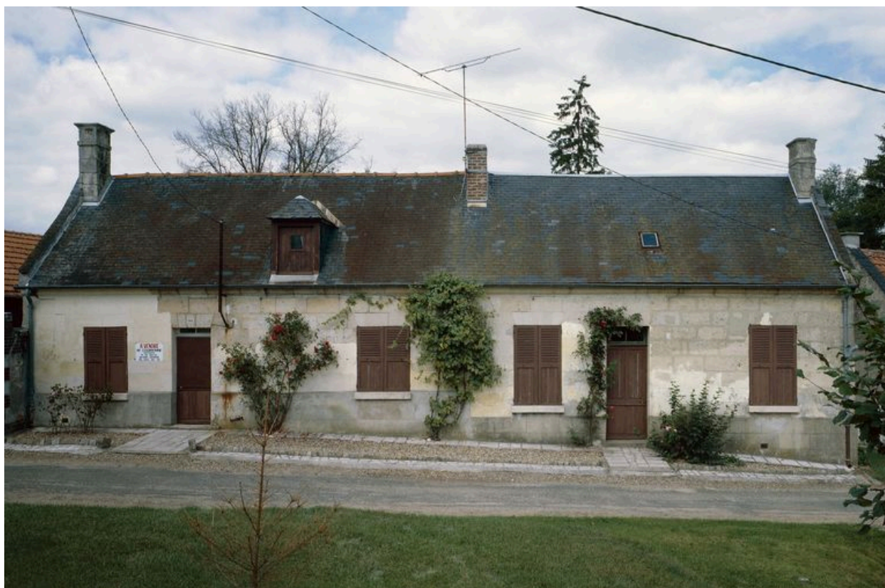
Logis. Elévation antérieure.
