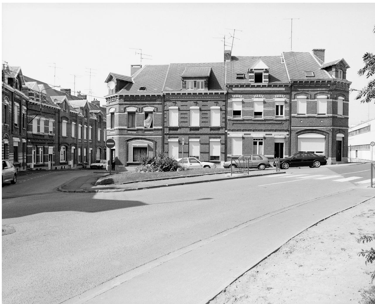
Vue générale d'un alignement de maisons ouvrières, rue Nicolas-Dufossez.
