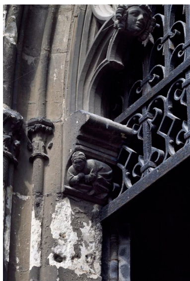
Vue d'un corbeau figuré. Phot. Thierry Lefébure IVR22_20110200034XA
