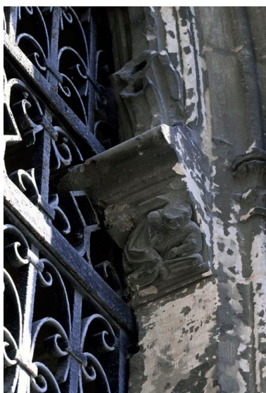
Vue d'un corbeau figuré. Phot. Thierry Lefébure IVR22_20110200035XA
