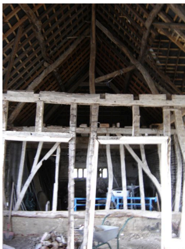
Autre vue intérieure, avec détail de la charpente. Phot. Inès Guérin IVR22_20058005171NUCA
