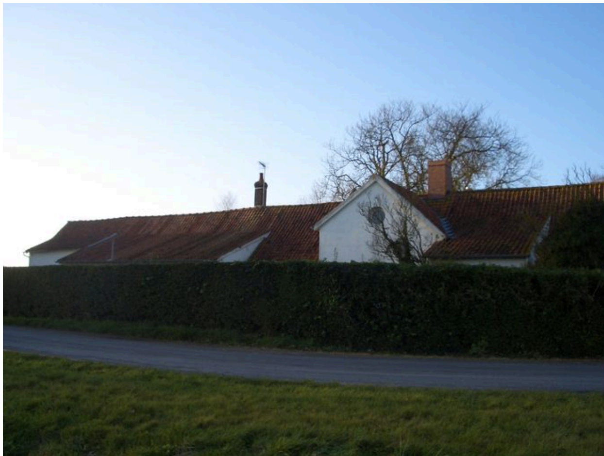
Vue postérieure du logis.
