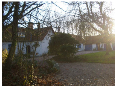
Vue générale. Phot. Inès Guérin IVR22_20068005662NUCA
