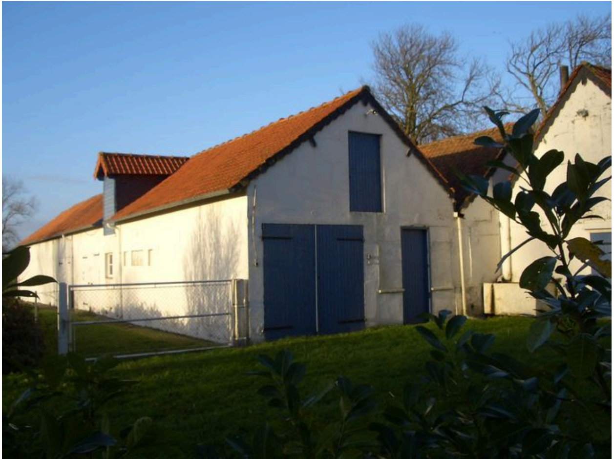
Vue postérieure des dépendances.
