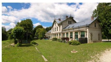
Emprise des voies, quais et bâtiment des voyageurs vus depuis l'est. Phot. Thierry Lefébure IVR32_20200600089NUC2AQ
