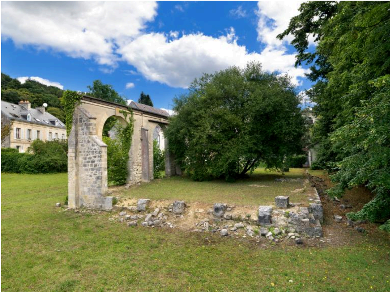
Ruines de la halle des marchandises. Plate-forme de chargement des marchandises ouvrant sur les anciennes voies.
