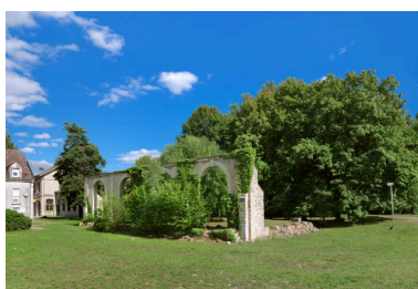
Ruines de la halle des marchandises. Arcades ouvrant sur la place de chargement au nord des voies. Phot. Thierry Lefébure IVR32_20200600086NUC2A
