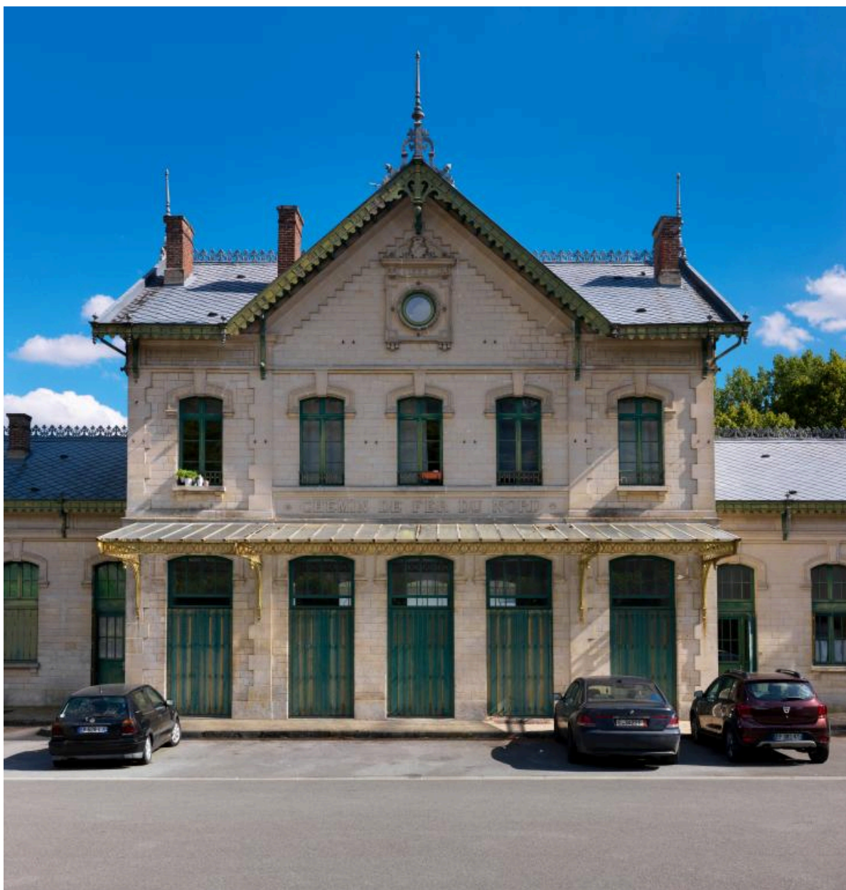
Vue de détail du pavillon du bâtiment des voyageurs (élévation nord donnant sur le parvis). Marquise abritant l'accès à l'ancien hall des guichets.
