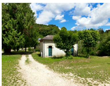
Pavillon des cabinets d'aisance, hommes et femmes, situé à l'est de la gare. Phot. Thierry Lefébure IVR32_20200600091NUC2A
