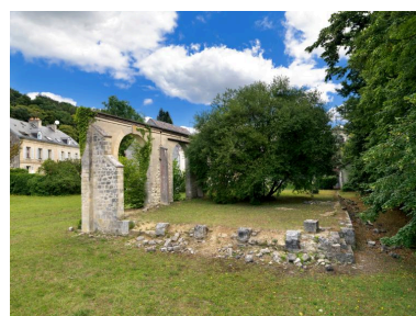
Ruines de la halle des marchandises. Plate-forme de chargement des marchandises ouvrant sur les anciennes voies. Phot. Thierry Lefébure IVR32_20200600087NUC2A
