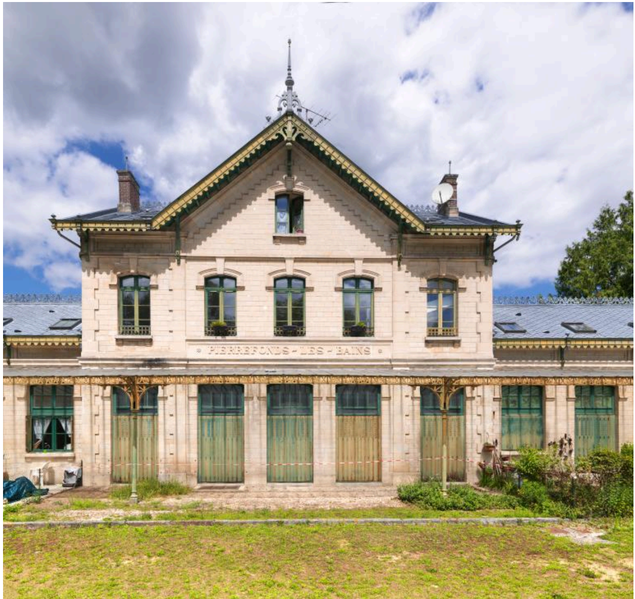
Vue de détail de l'élévation sud du pavillon central du bâtiment des voyageurs avec la marquise abritant un quai.
