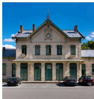
Vue de détail du pavillon du bâtiment des voyageurs (élévation nord donnant sur le parvis). Marquise abritant l'accès à l'ancien hall des guichets. Phot. Thierry Lefébure IVR32_20200600085NUC2A
