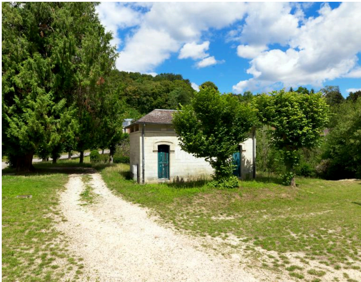
Pavillon des cabinets d'aisance, hommes et femmes, situé à l'est de la gare.
