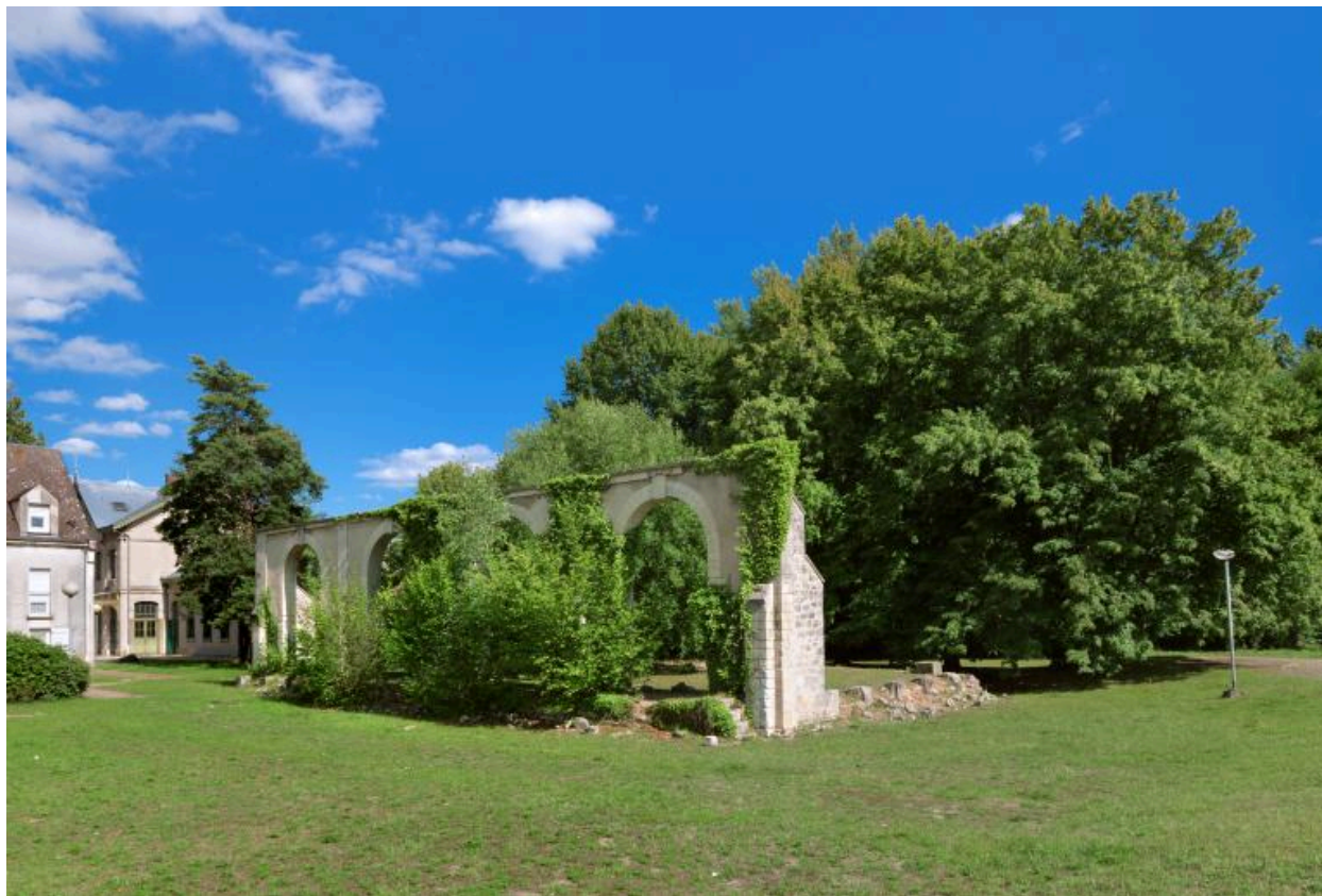
Ruines de la halle des marchandises. Arcades ouvrant sur la place de chargement au nord des voies.
