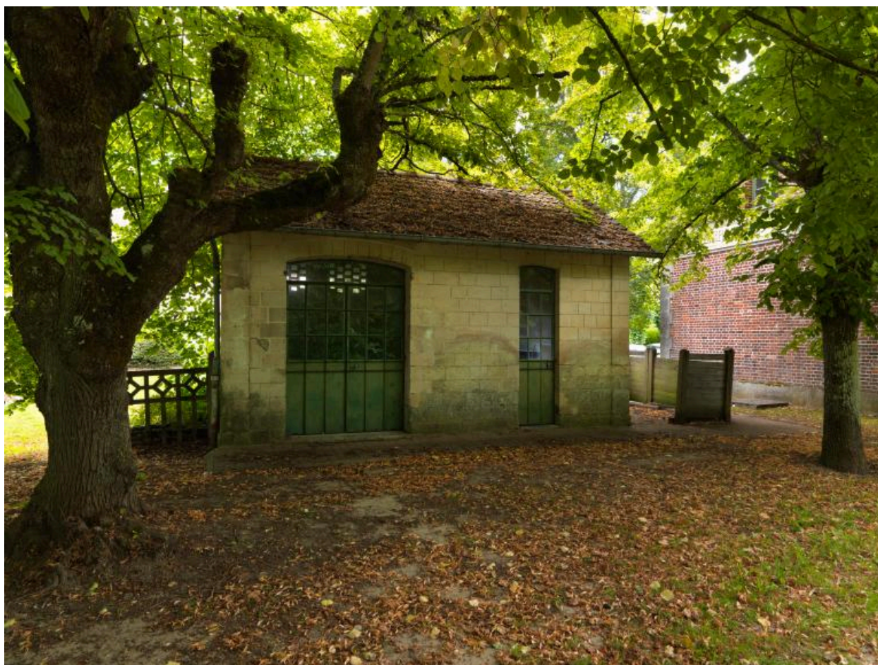
Pavillon de lampisterie à l'ouest du bâtiment des voyageurs, aujourd'hui local poubelles.
