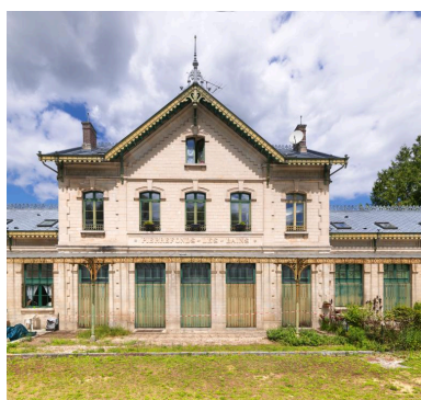
Vue de détail de l'élévation sud du pavillon central du bâtiment des voyageurs avec la marquise abritant un quai. Phot. Thierry Lefébure IVR32_20200600090NUC2A
