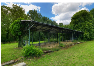
Marquise de l'abri des voyageurs sur le quai central entre l'emprise des anciennes voies. Phot. Thierry Lefébure IVR32_20200600092NUC2A
