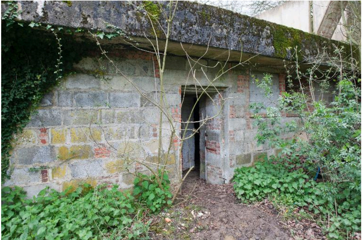
Vue de détail d'une élévation.
