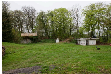
Vue générale des deux abris-casernements. Phot. Pierre Thibaut IVR31_20126201701NUCA
