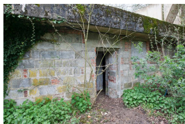
Vue de détail d'une élévation. Phot. Pierre Thibaut IVR31_20126201705NUCA
