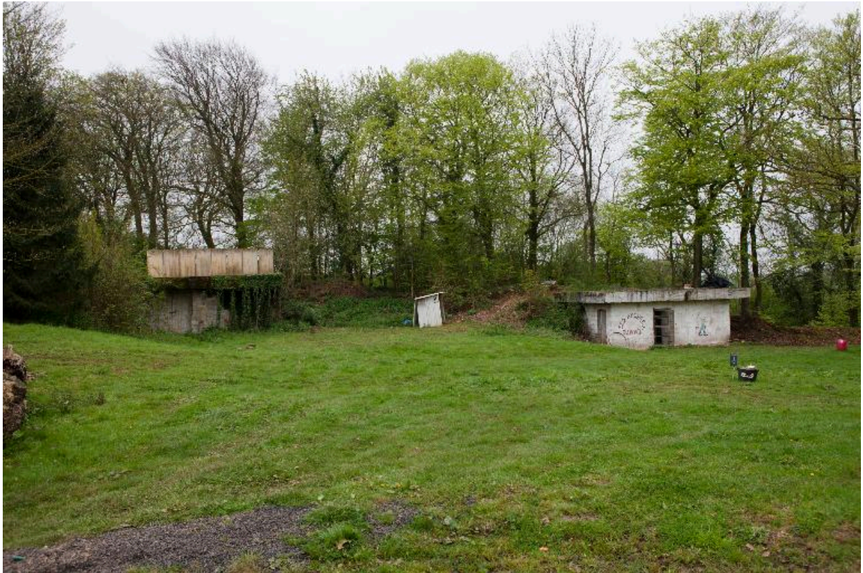
Vue générale des deux abris-casernements.
