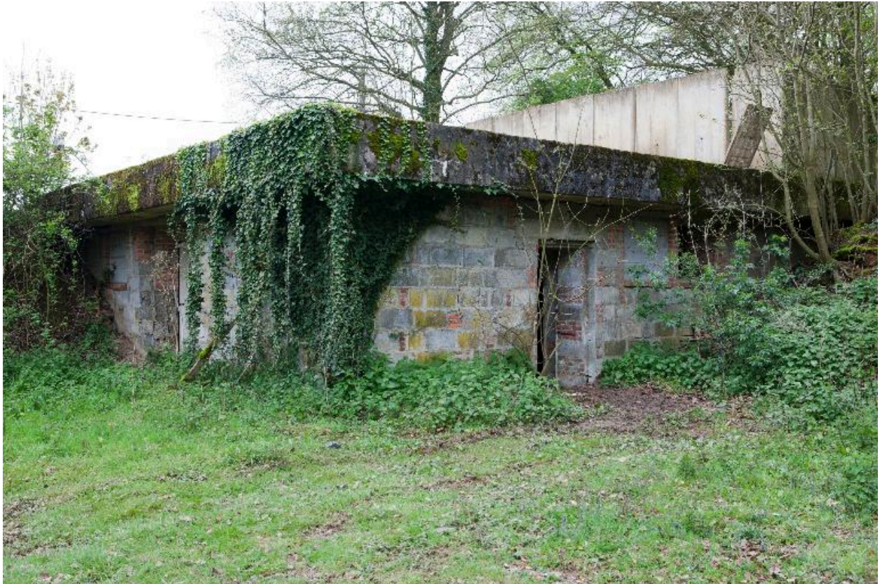
Vue générale du premier abri.
