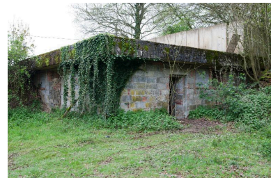
Vue générale du premier abri. Phot. Pierre Thibaut IVR31_20126201712NUCA
