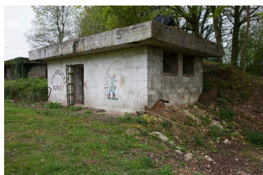
Vue générale du second abri. Phot. Pierre Thibaut IVR31_20126201714NUCA
