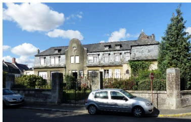
Vue de situation. Phot. Isabelle Barbedor IVR32_20178005235NUCA
