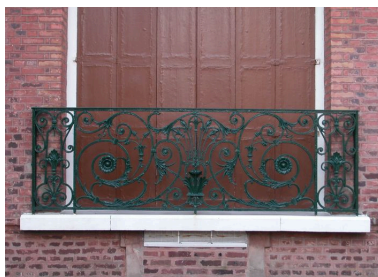
Détail du décor de fonderie du garde-corps du rez-de-chaussée. Phot. Elisabeth Justome IVR22_20058002534NUCA
