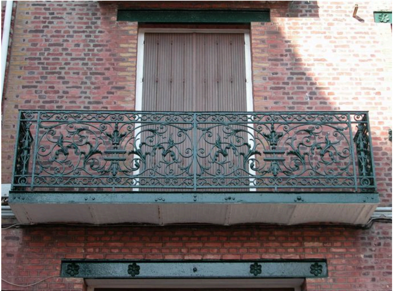
Détail du décor de fonderie du garde-corps de balcon situé au premier étage-carré.
