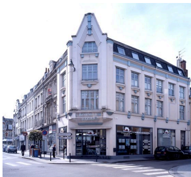
Vue générale. Phot. Pierre Thibaut IVR31_20086200156VA
