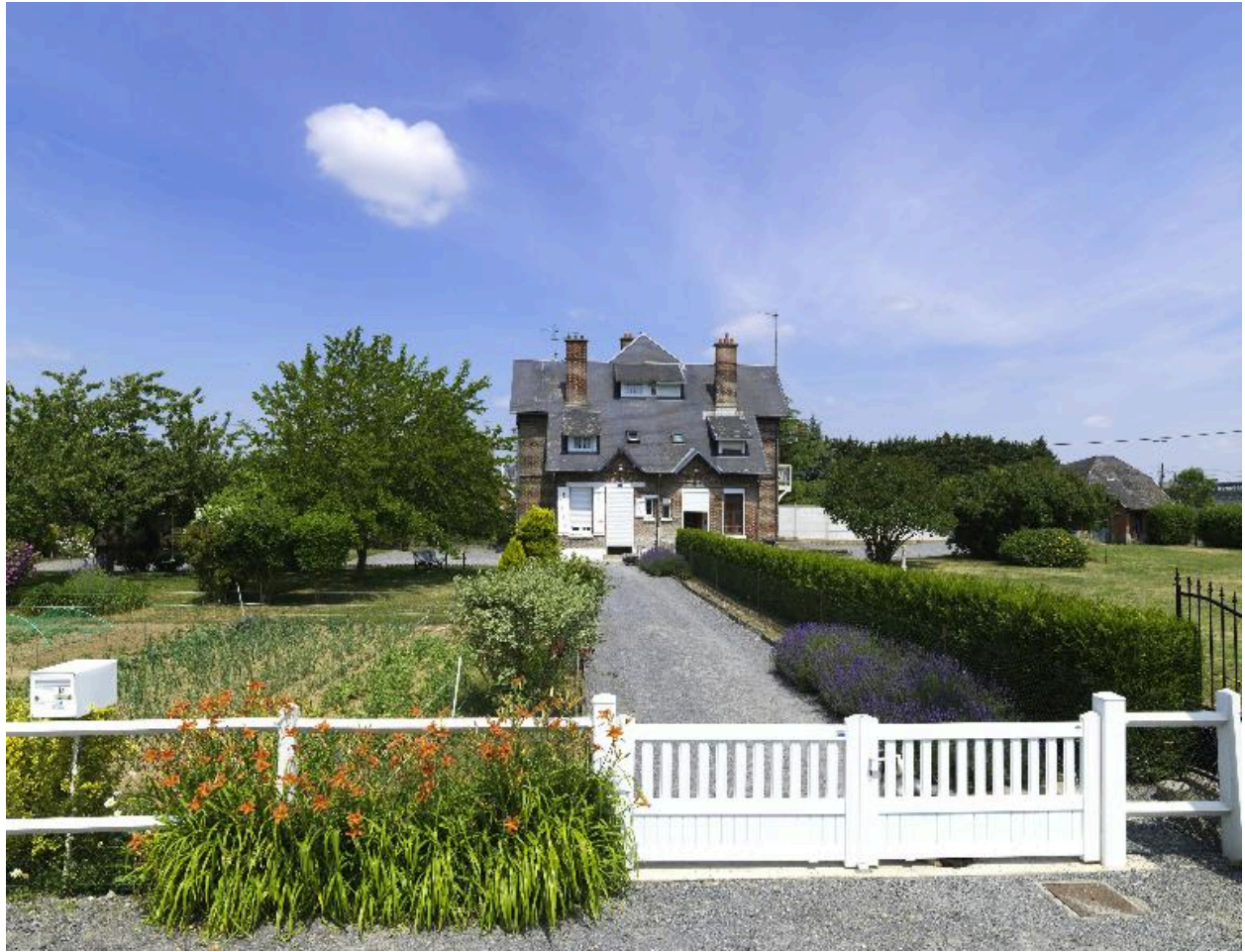
Vue d'ensemble d'une maison ouvrière au milieu de sa parcelle (14-16 rue Lucie).
