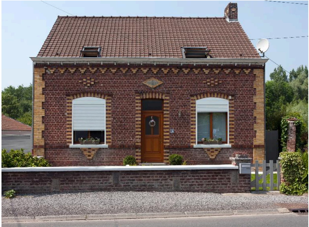
Vue générale de deux maisons de bateliers.
