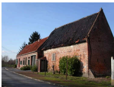
La bergerie de l'abbaye. Phot. Sophie Luchier IVR31_20075900225NUCA
