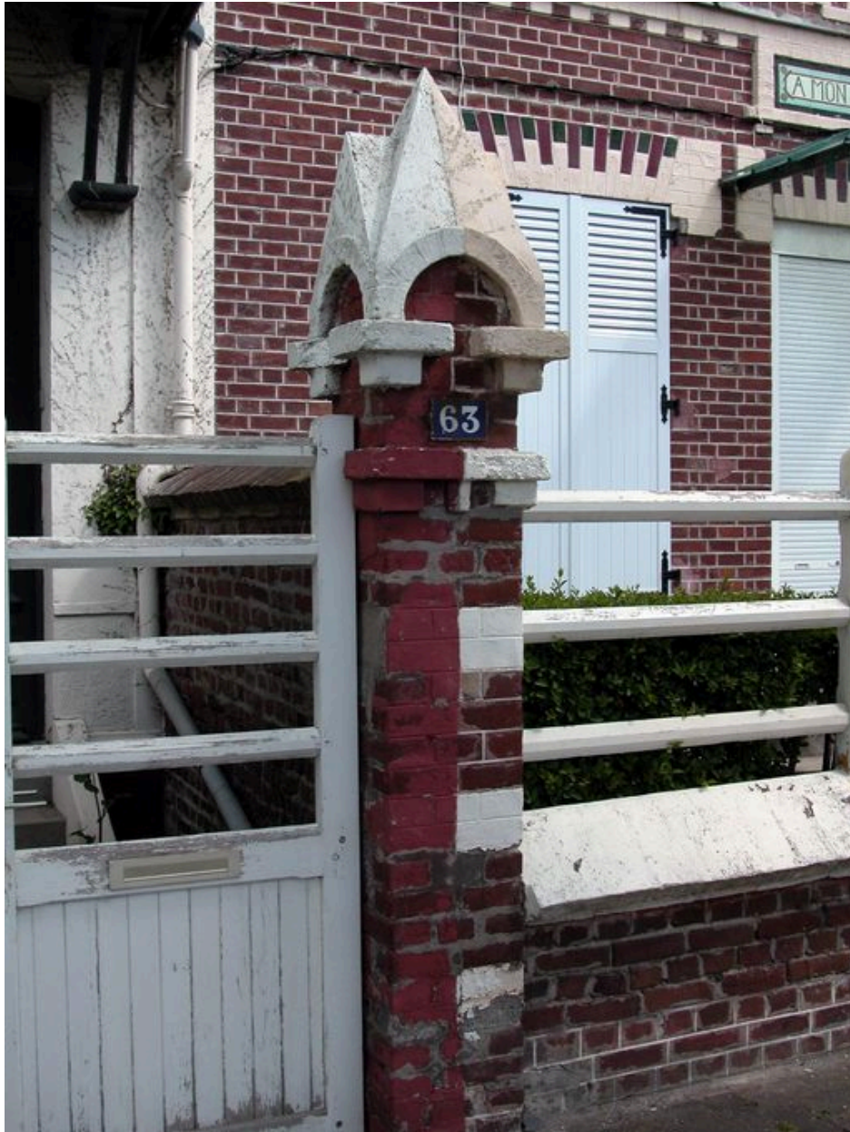
Détail d'un pilier du mur de clôture.
