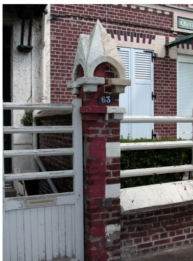
Détail d'un pilier du mur de clôture. Phot. Elisabeth Justome IVR22_20058002849NUCA
