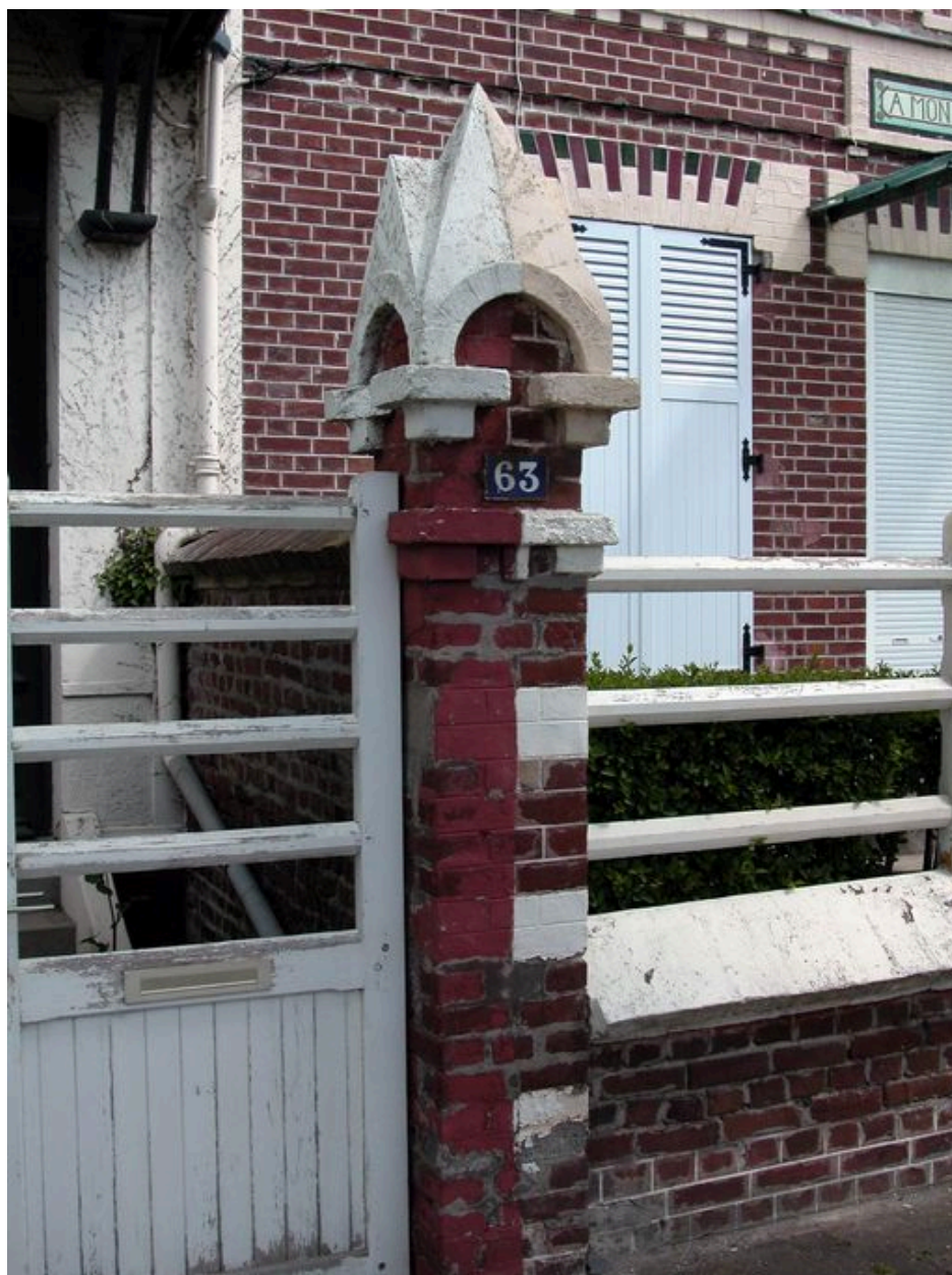
Détail d'un pilier du mur de clôture.
