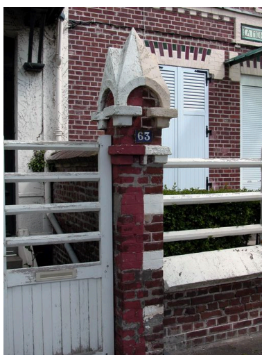
Détail d'un pilier du mur de clôture.
