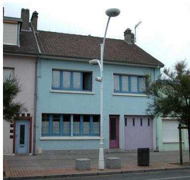
Vue d'ensemble. Phot. Elisabeth Justome IVR22_20058004019NUCA
