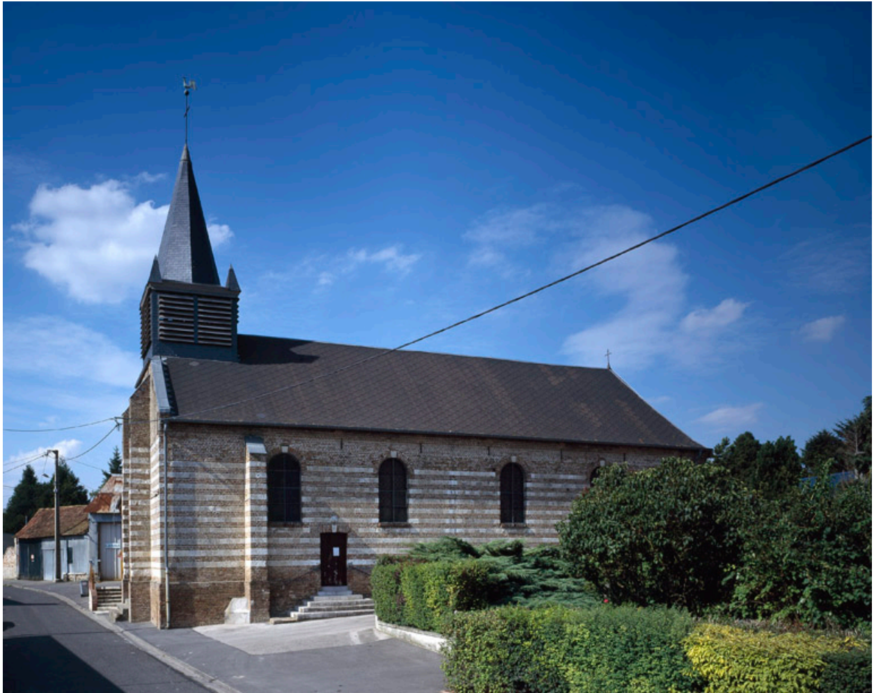
Vue générale depuis le sud.
