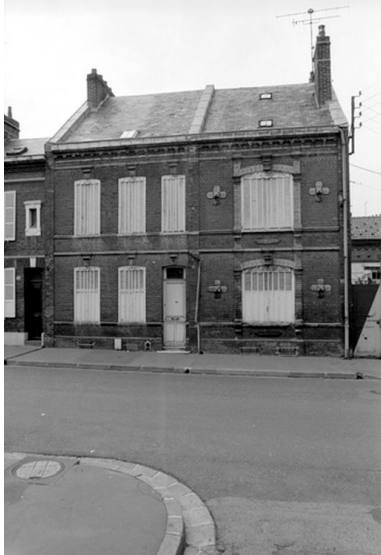
Logement patronal ou conciergerie, élévation antérieure.
