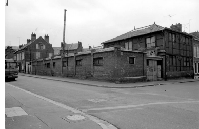
Ateliers de fabrication, flanc nord est. Phot. Benoît Dufournier IVR22_19918000251Z
