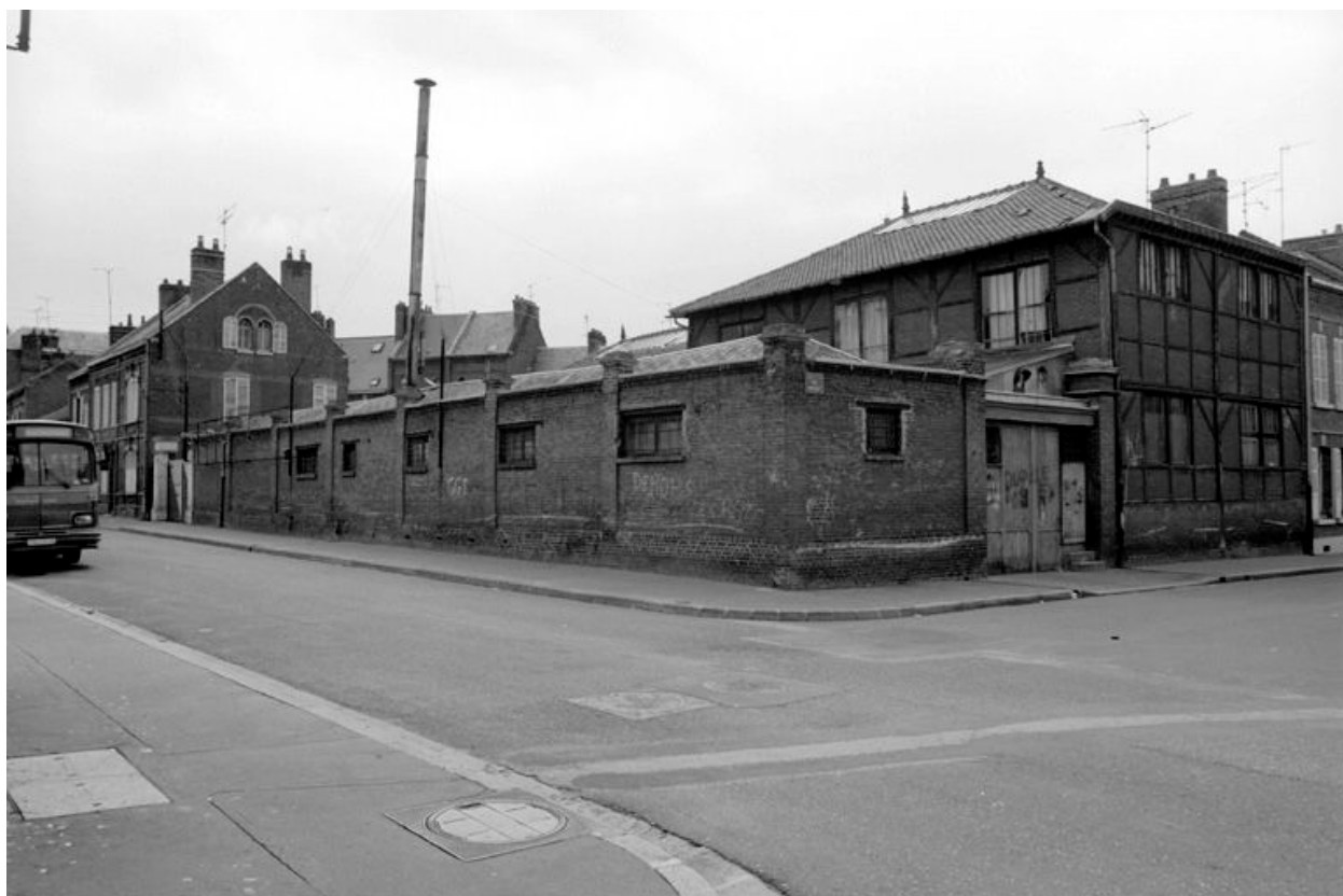
Ateliers de fabrication, flanc nord est.
