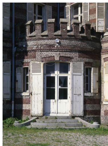
Détail du porche hors-oeuvre comportant l'entrée.
