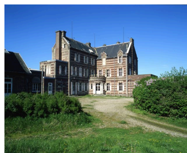
Vue d'ensemble du corps de logis principal, angle est.
