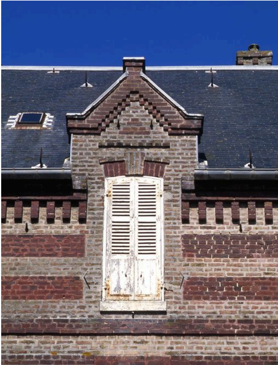
Détail d'une fenêtre de lucarne à fronton-pignon.
