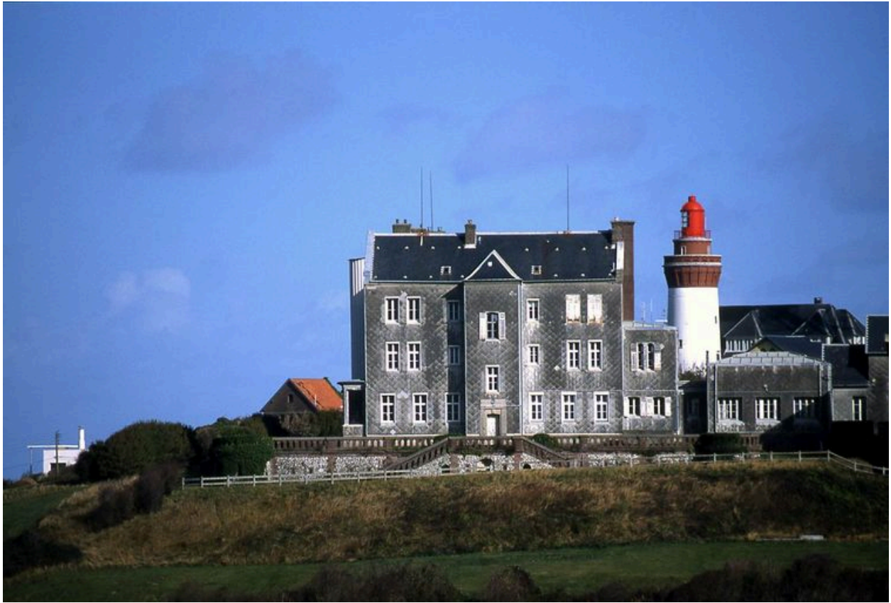
Vue d'ensemble depuis le lotissement du Bel-Air.
