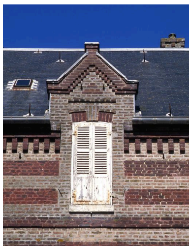
Détail d'une fenêtre de lucarne à fronton-pignon.
