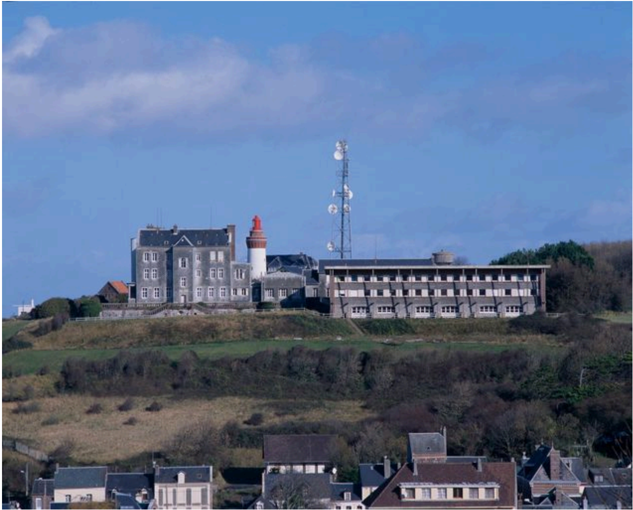
Vue d'ensemble depuis le lotissement du Bel-Air.
