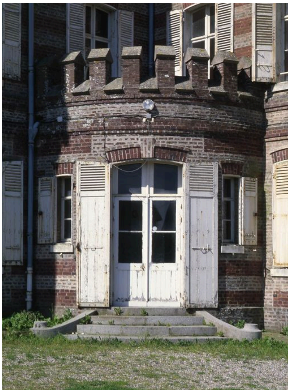
Détail du porche hors-oeuvre comportant l'entrée.
