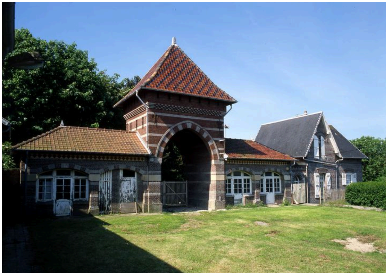
Les anciennes remise et écuries formant corps d'entrée et la conciergerie.
