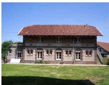
Un bâtiment de la cour des communs. Phot. Marie-Laure Monnehay-Vulliet IVR22_20058001150XA
