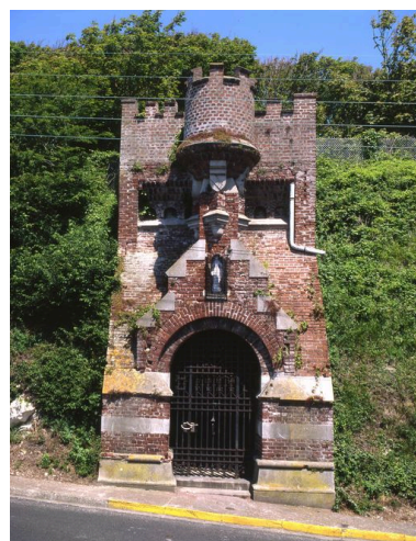
Vue d'ensemble de la porte élevée rue Saint-Pierre. Phot. Marie-Laure Monnehay-Vulliet IVR22_20058001166XA
