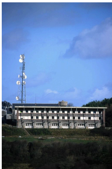
Le gymnase construit pour les besoins de la colonie de vacances. Phot. Marie-Laure Monnehay-Vulliet IVR22_20028000074ZA
