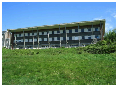
Le gymnase, élévation sud. Phot. Marie-Laure Monnehay-Vulliet IVR22_20058000943XA
