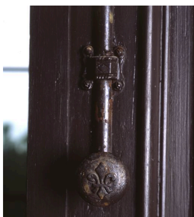
Détail d'une crémone située dans une des pièces de réception.
