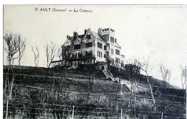
La propriété avant transformations, élévations sur mer, carte postale, 1ère moitié 20e siècle (coll. part.). Phot. Monnehay-Vulliet Marie-Laure IVR22_20048000096NUCAB
