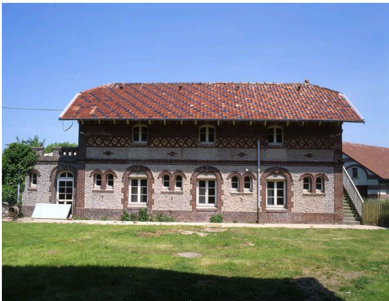
Un bâtiment de la cour des communs.
