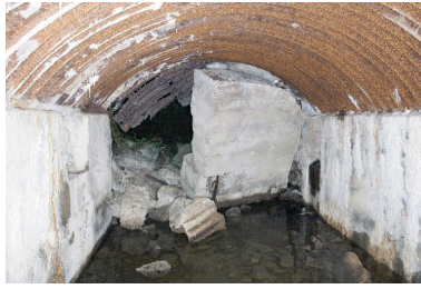
Vue intérieure, vers l'ouest Phot. Pierre Thibaut IVR31_20155900617NUCA
