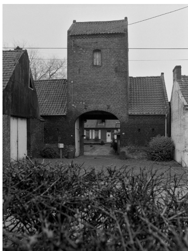
Le porche-pigeonnier depuis la cour. Phot. Philippe Dapvril IVR31_20055900012X
