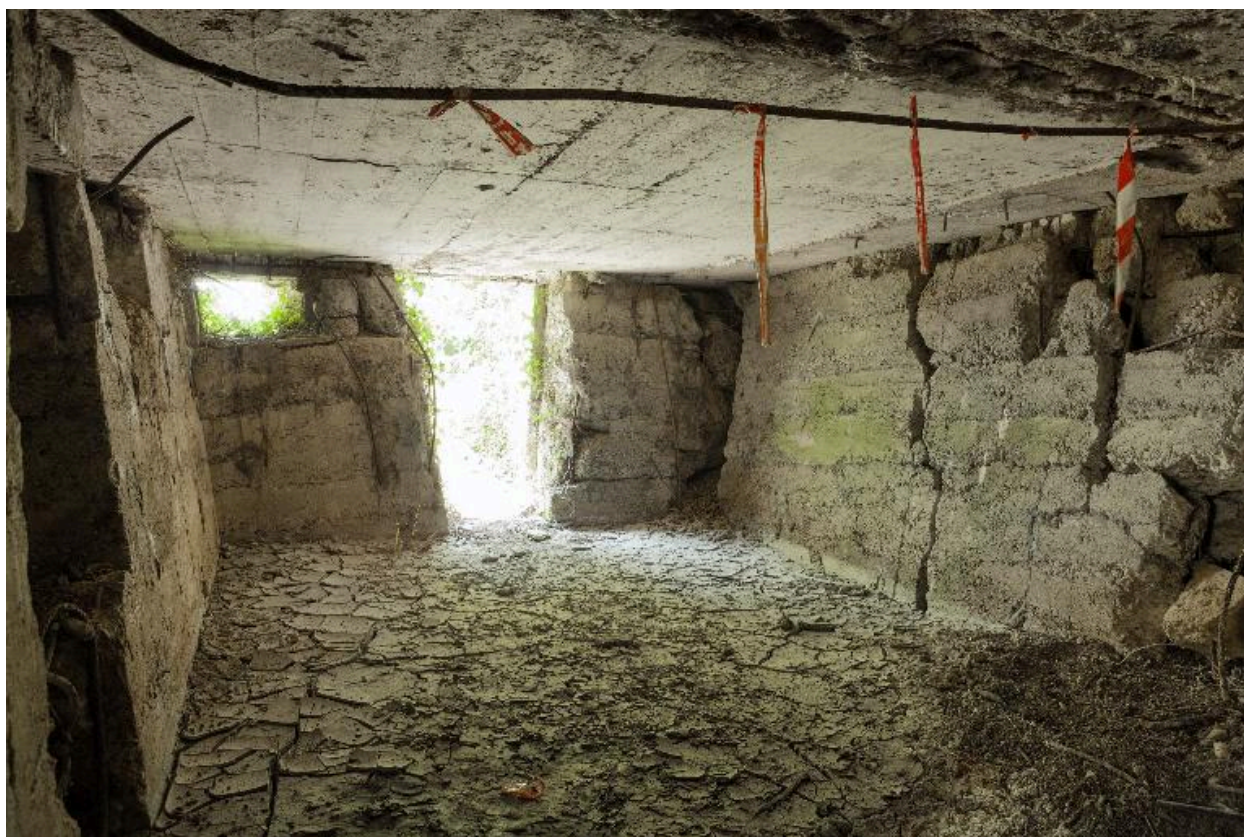
Vue intérieure vers la sortie sud
