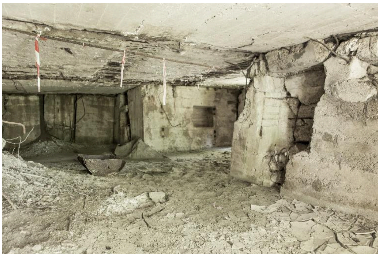
Vue intérieure depuis l'entrée sud
