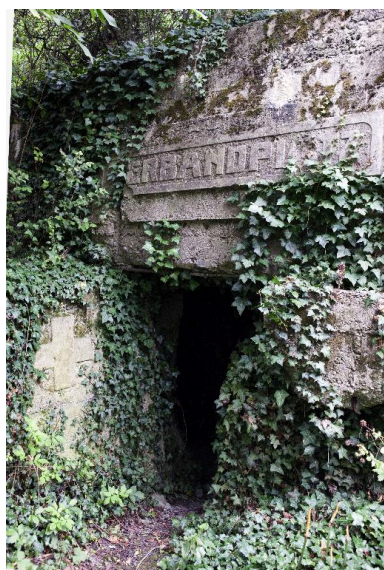
Entrée sud surmontée encadrée de ses deux cartouches Phot. Pierre Thibaut IVR31_20155901476NUCA
