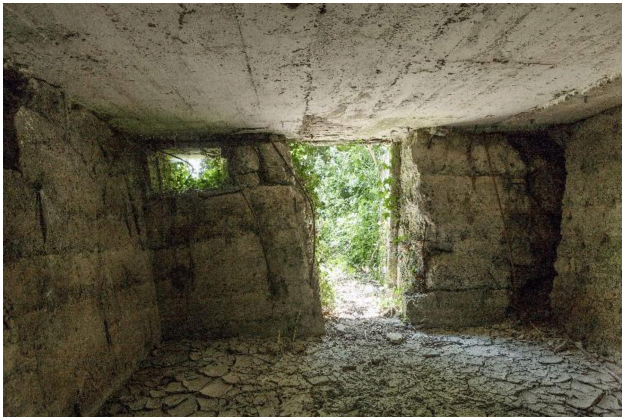
Vue intérieure vers la sortie sud
