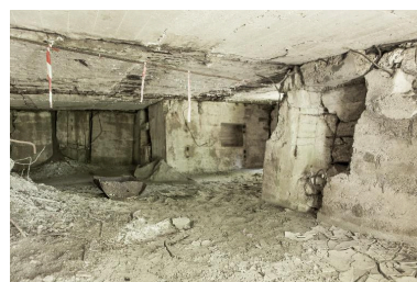
Vue intérieure depuis l'entrée sud Phot. Jean-Marc Ramette IVR31_20145905198NUCA
