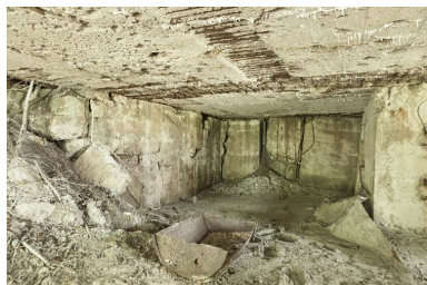
Vue intérieure vers l'extrémité nord de l'édifice Phot. Jean-Marc Ramette IVR31_20145905203NUCA
