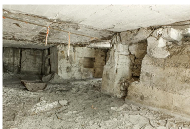
Vue intérieure depuis l'entrée sud Phot. Jean-Marc Ramette IVR31_20145905199NUCA
