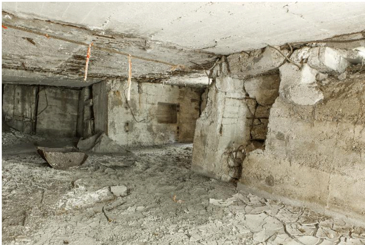
Vue intérieure depuis l'entrée sud
