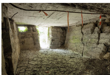
Vue intérieure vers la sortie sud Phot. Jean-Marc Ramette
