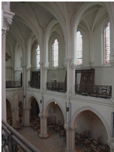
Vue générale et de situation Phot. Bruno Decrock IVR31_20106204370NUCA
