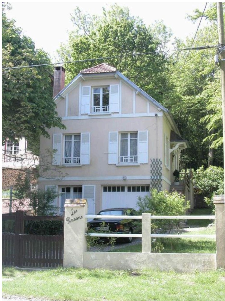
Garage dans-oeuvre de la maison dite Les Pinsons.
