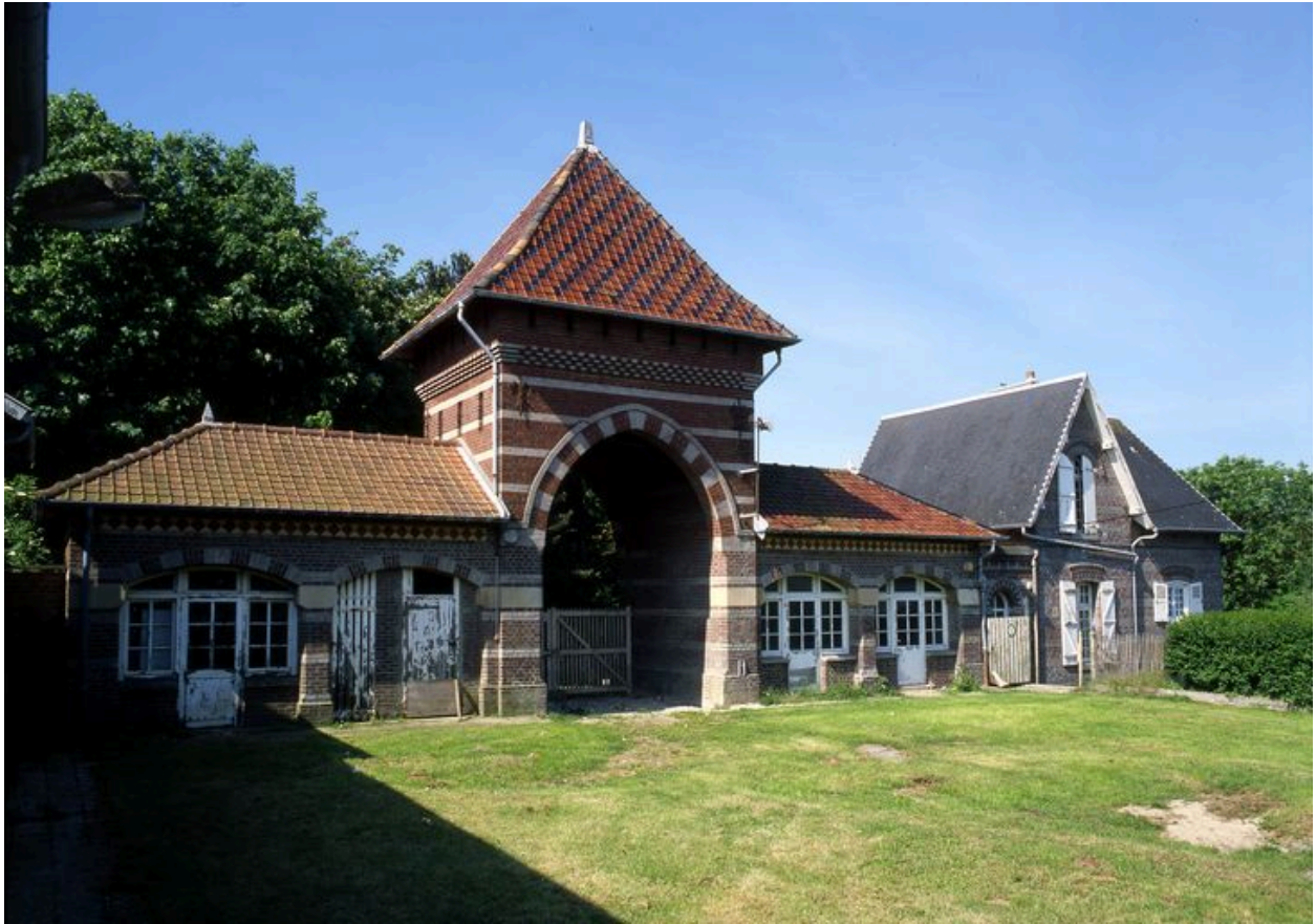
Remises et conciergerie de la maison dite Les Moulinets.
