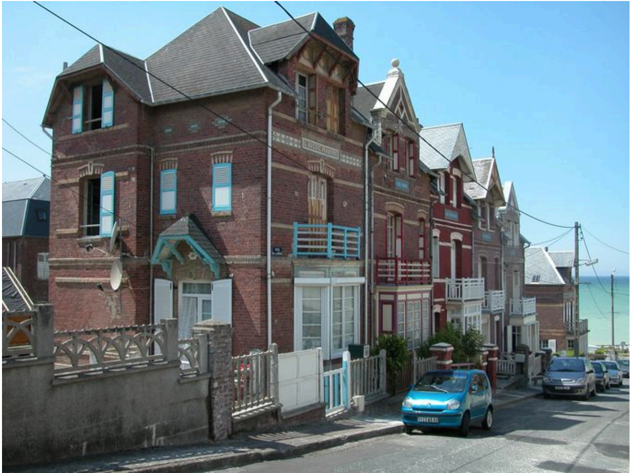
Maisons rue de la Brise.
