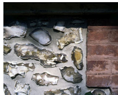
Détail d'une partie du gros-oeuvre en silex de la maison dite La Sauvagère. Phot. Marie-Laure Monnehay-Vulliet IVR22_20058001696XA
