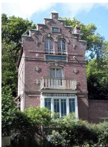
Maison dite Les Pervenches, 1 travée en façade et entrée latérale. Phot. Elisabeth Justome IVR22_20048001369NUCA
