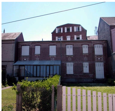
Type de la maison à plusieurs logements accolés et superposés. Phot. Elisabeth Justome IVR22_20048001474NUCA
