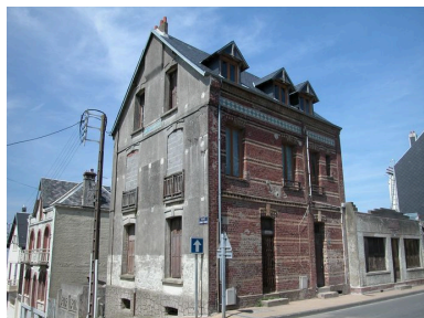
Type de la maison de ville à deux logements accolés, maison dite La Chaumière. Phot. Elisabeth Justome IVR22_20048001494NUCA
