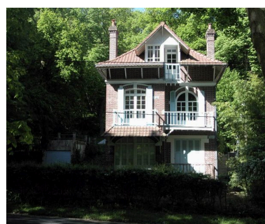
Maison à plusieurs logements superposés. Phot. Elisabeth Justome IVR22_20048001371NUCA
