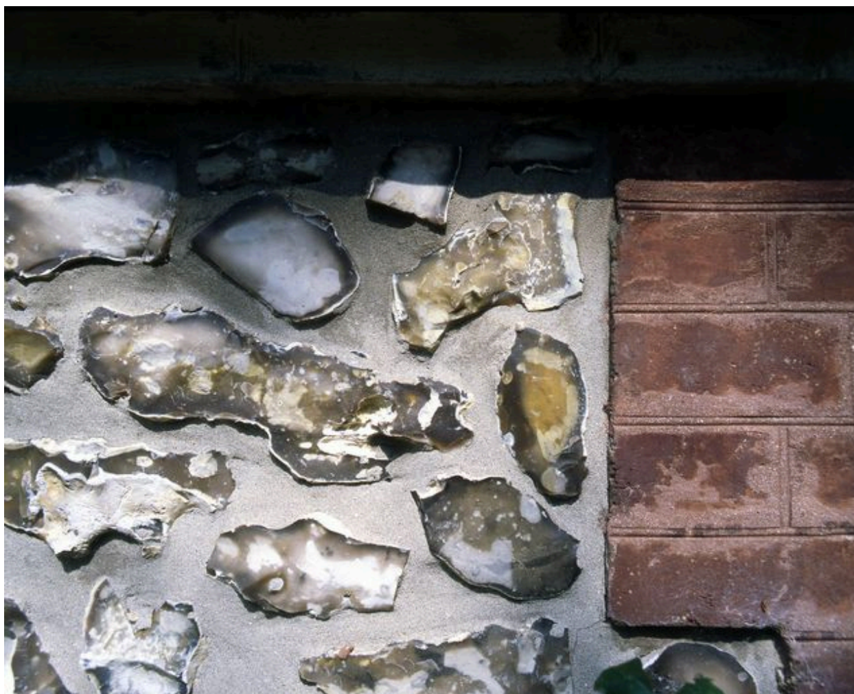
Détail d'une partie du gros-oeuvre en silex de la maison dite La Sauvagère.
