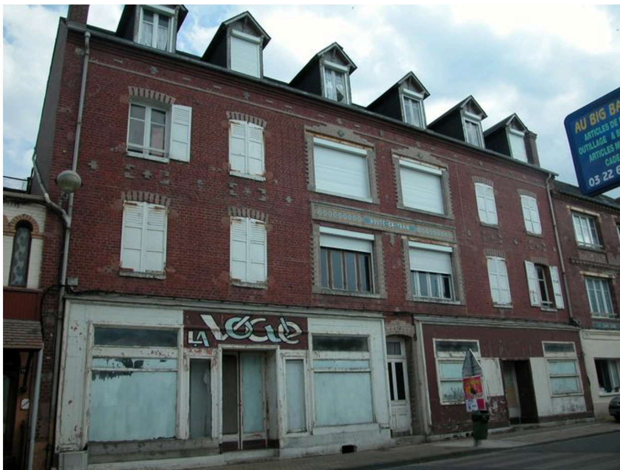
Immeuble avec deux magasins de commerce au rez-de-chaussée.
