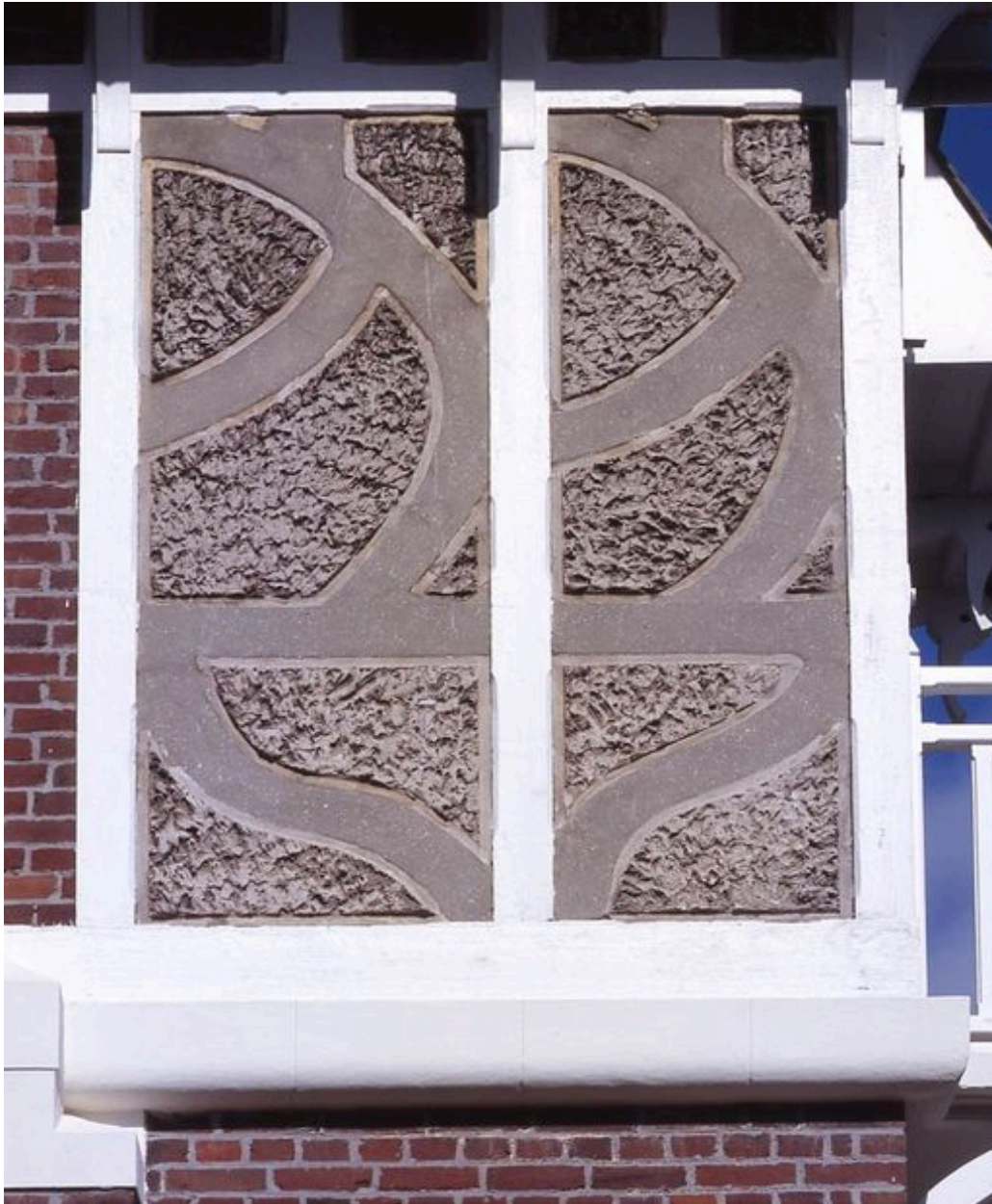
Détail des faux pans de bois curvilignes en ciment, par Théophile Bourgeois architecte (Les Canards).
