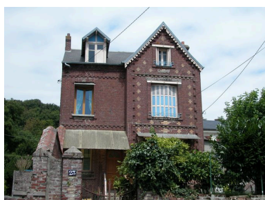
Maison à avancée latérale. Phot. Elisabeth Justome IVR22_20058003386NUCA
