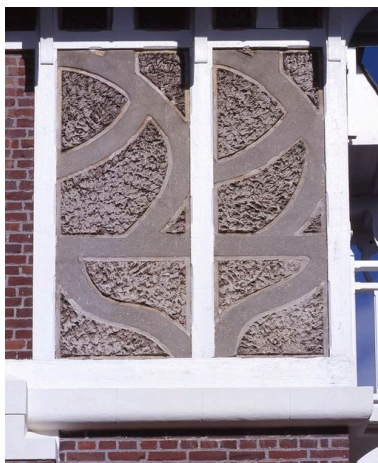
Détail des faux pans de bois curvilignes en ciment, par Théophile Bourgeois architecte (Les Canards). Phot. Marie-Laure Monnehay-Vulliet IVR22_20048000192XA
