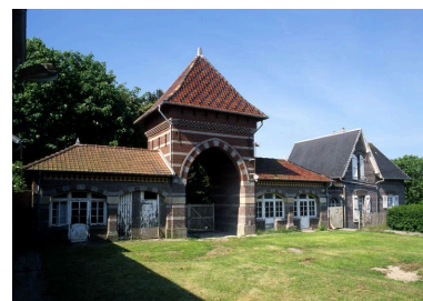
Remises et conciergerie de la maison dite Les Moulins. Phot. Marie-Laure Monnehay-Vulliet IVR22_20058001147XA
