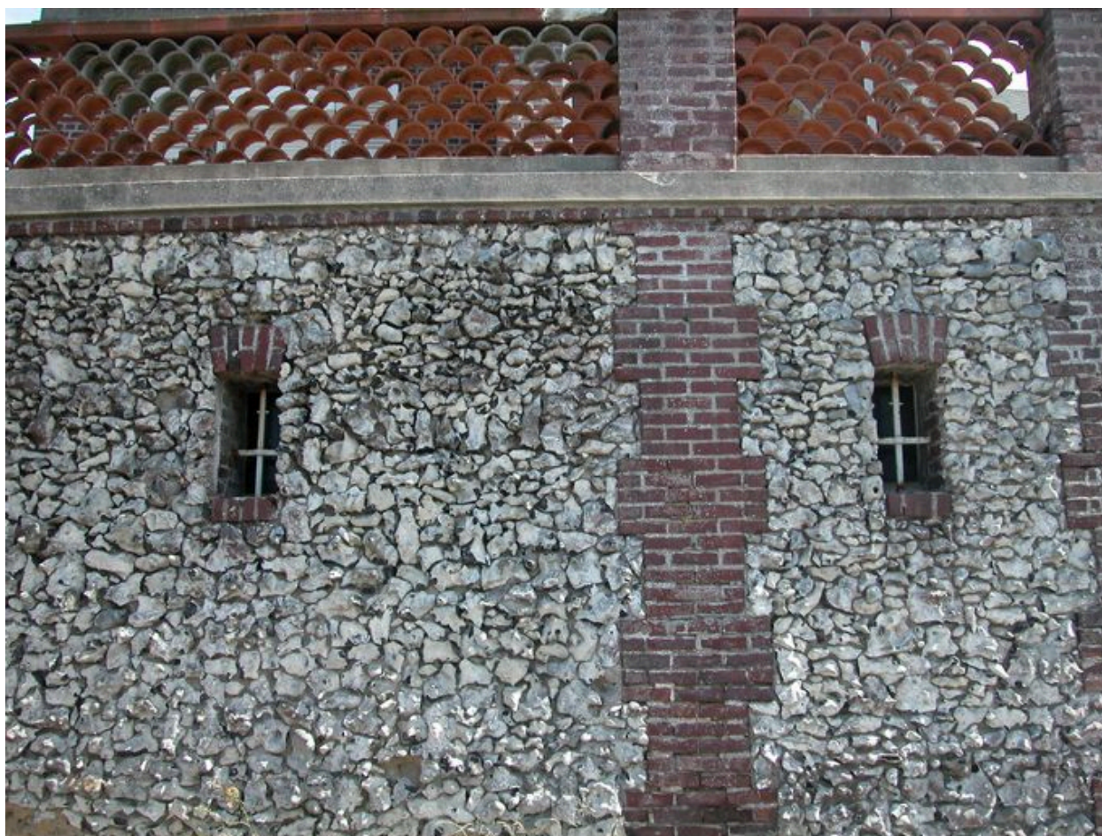
Détail du mur de soutènement de la maison dite Villa Sainte-Cécile.
