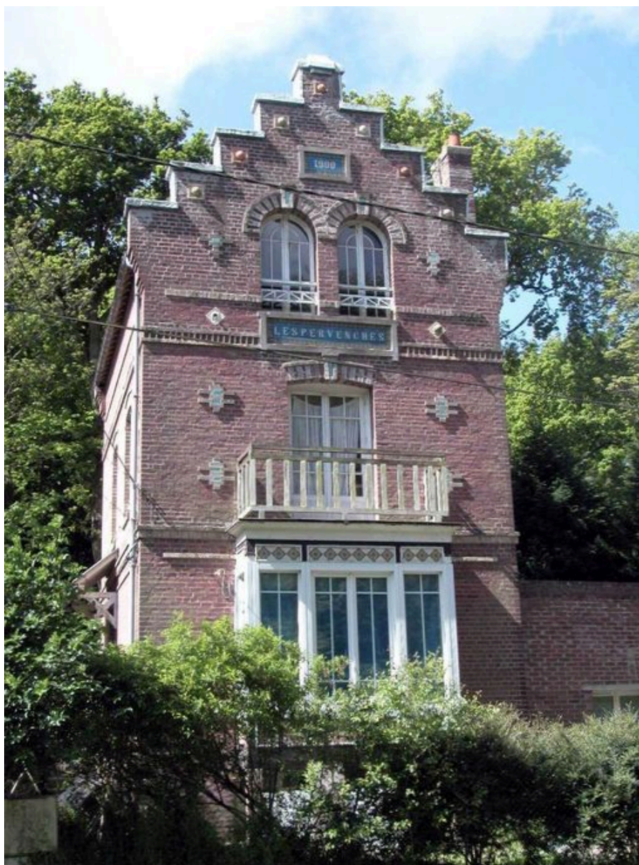
Maison dite Les Pervenches, 1 travée en façade et entrée latérale.
