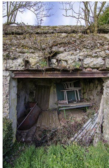
Accès à la partie est de l'édifice. Phot. Jean-Marc Ramette IVR32_20165901135NUCA
