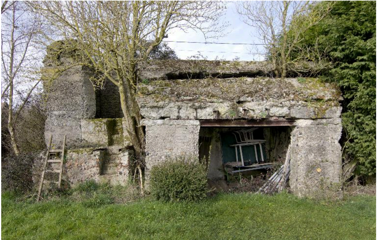
Vue générale vers le nord. A gauche l'accès à l'observatoire casematé
