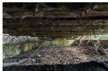
Depuis la tour d'observation, vue intérieure du double couverture de la partie est de l'édifice, servant de chambre d'explosion Phot. Jean-Marc Ramette IVR32_20165901142NUCA
