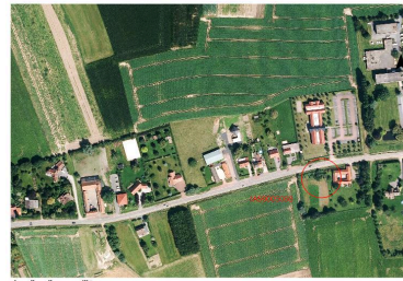
Situation de l'édifice sur une photographie aérienne de 2014 Phot. Jean-Marc Ramette IVR32_20175901524NUCA
