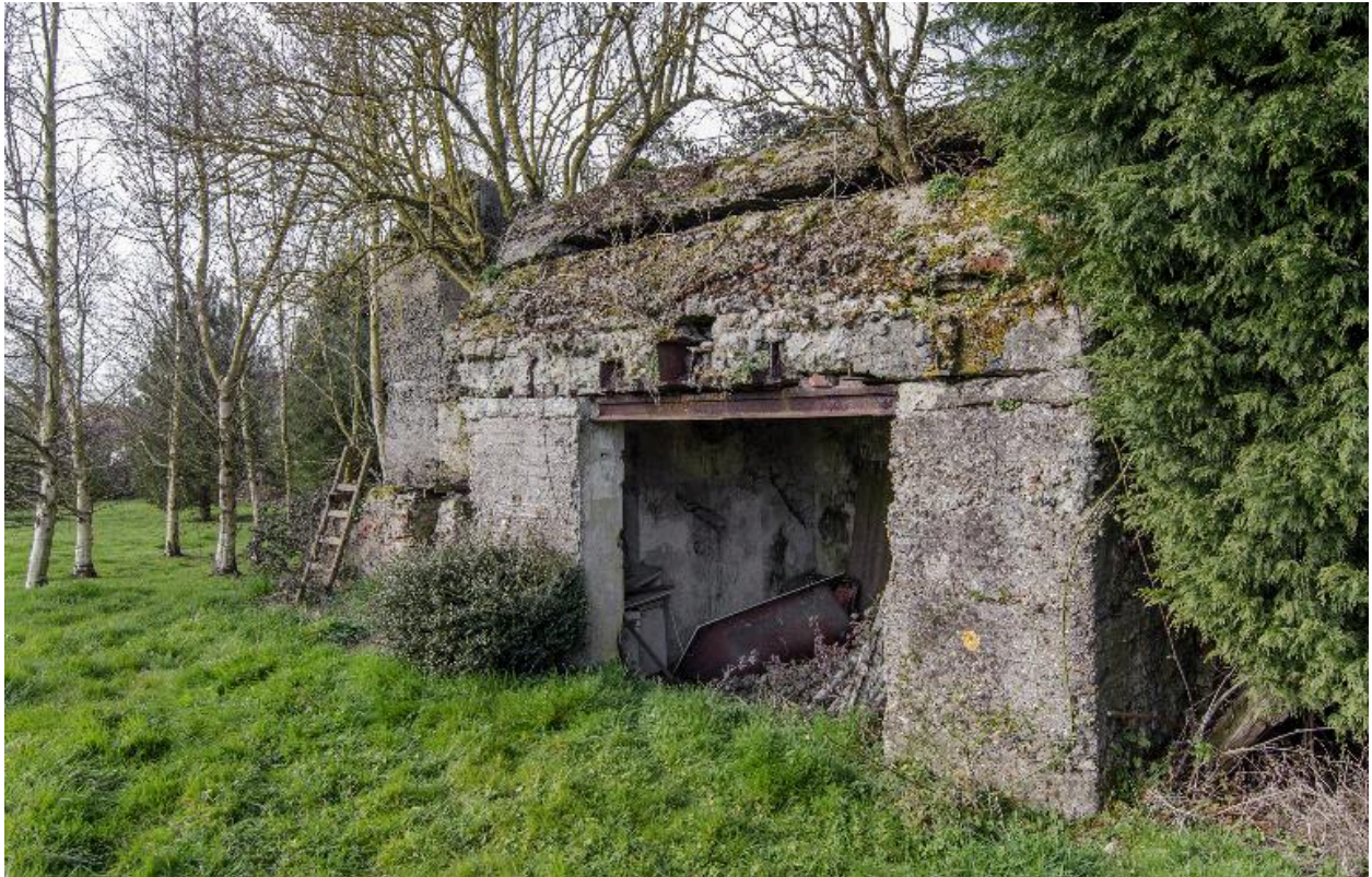
Vue de trois-quarts vers le nord-ouest
