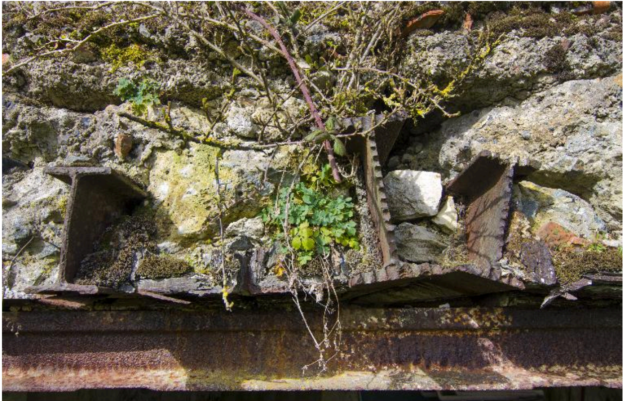
Fers de sontènement en I dela partie est de l'édifice
