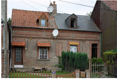
Vue d'ensemble sur rue. Phot. Bertrand Fournier IVR22_20098005134NUCA
