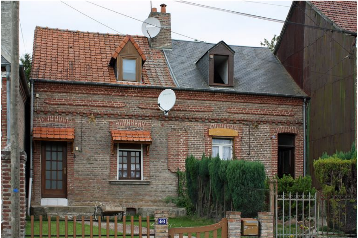
Vue d'ensemble sur rue.
