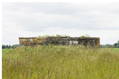
Vue latérale, vers le sud-ouest Phot. Jean-Marc Ramette IVR31_20145905374NUCA
