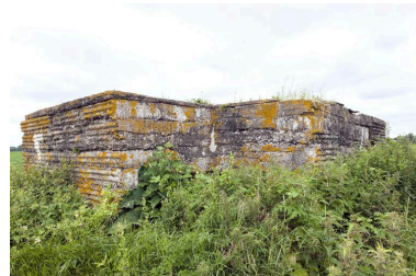
Vue de trois-quarts, vers le nord-ouest. Au premier plan, l'entrée nord-est Phot. Jean-Marc Ramette IVR31_20145905375NUCA
