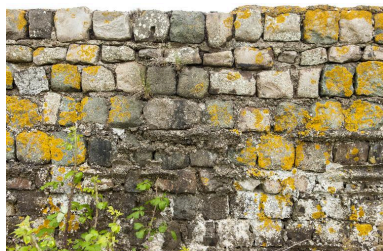
Détail de l'essentage de pavé de l'élévation nord-ouest Phot. Jean-Marc Ramette IVR31_20145905378NUCA
