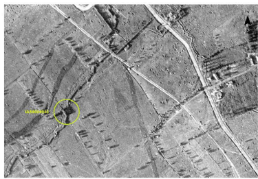
Situation de l'édifice sur une photographie aérienne britannique du 15/09/1918. Phot. Jean-Marc Ramette IVR32_20175900915NUCA
