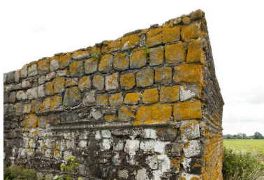
Angle nord-ouest Phot. Jean-Marc Ramette IVR31_20145905377NUCA
