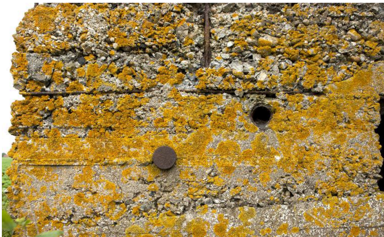
Elévation sud-ouest, détail
