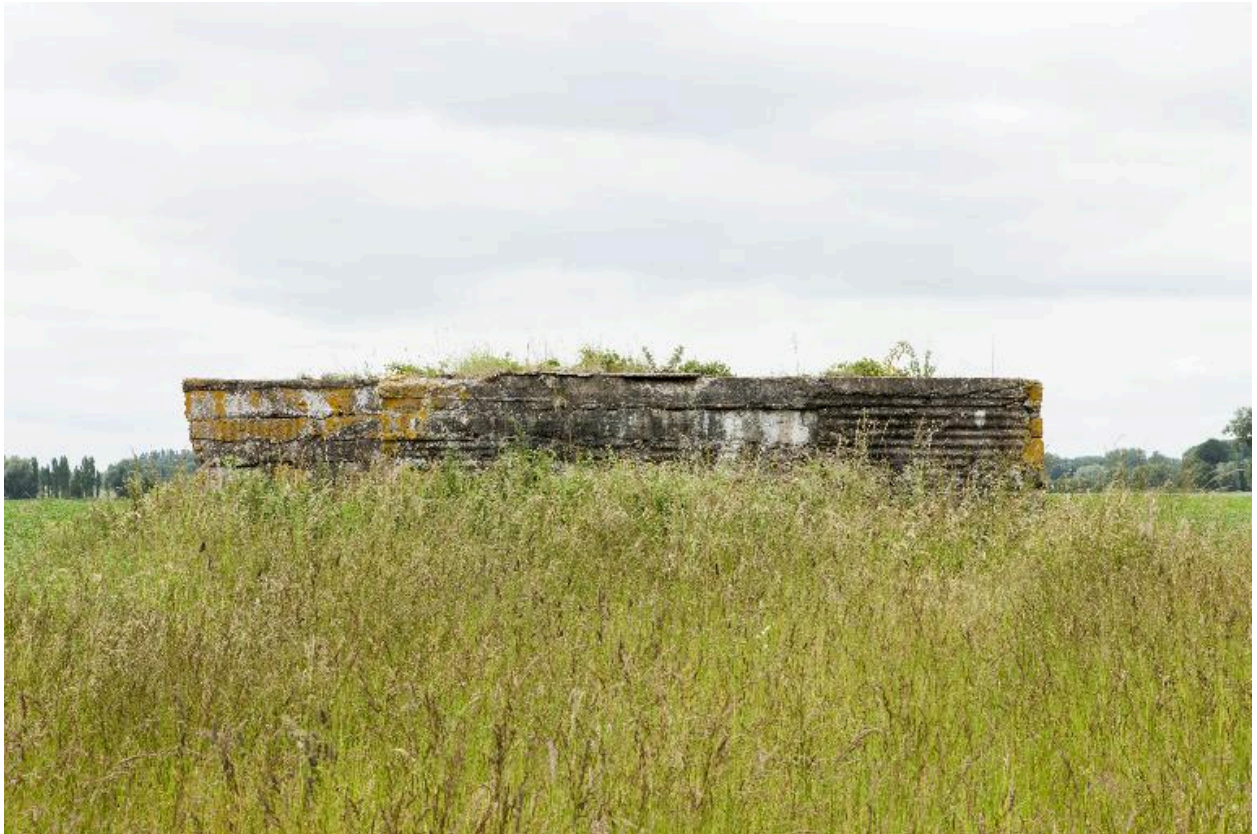
Vue latérale, vers le sud-ouest
