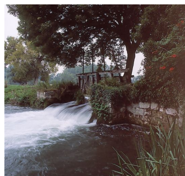
Les vannes de décharge.
