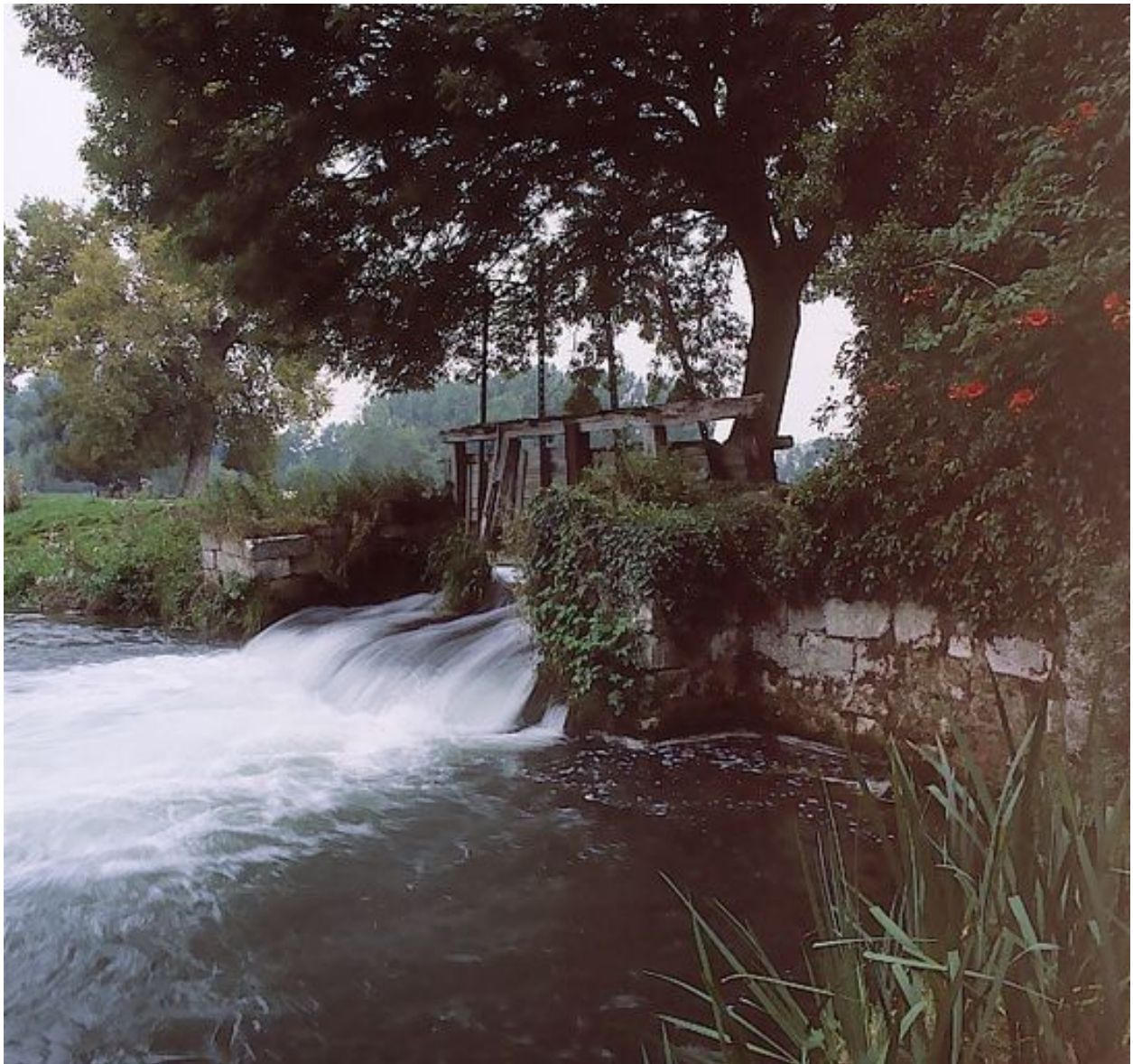
Les vannes de décharge.
