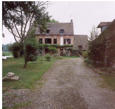
Vue générale de la façade sur cour.
