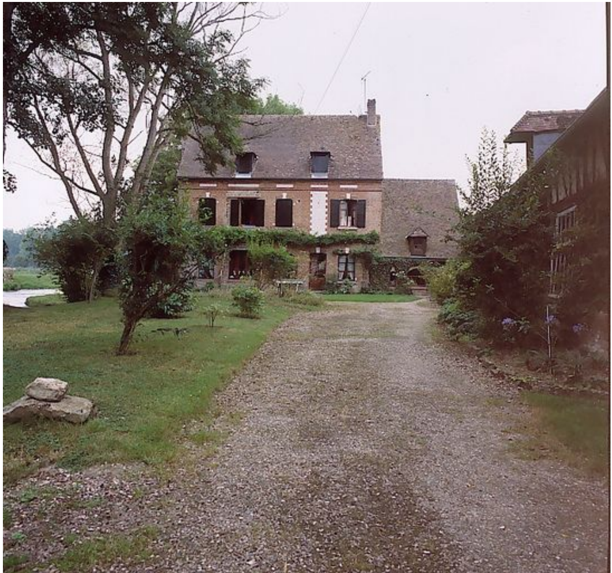
Vue générale de la façade sur cour.
