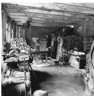
Intérieur de l'atelier de sciage.
