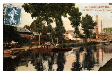
L'Usine de Rocourt vue depuis le Canal de Saint-Quentin vers 1900 (BM Saint-Quentin). Phot. Pillet Frédéric IVR22_20060205300NUCAB
