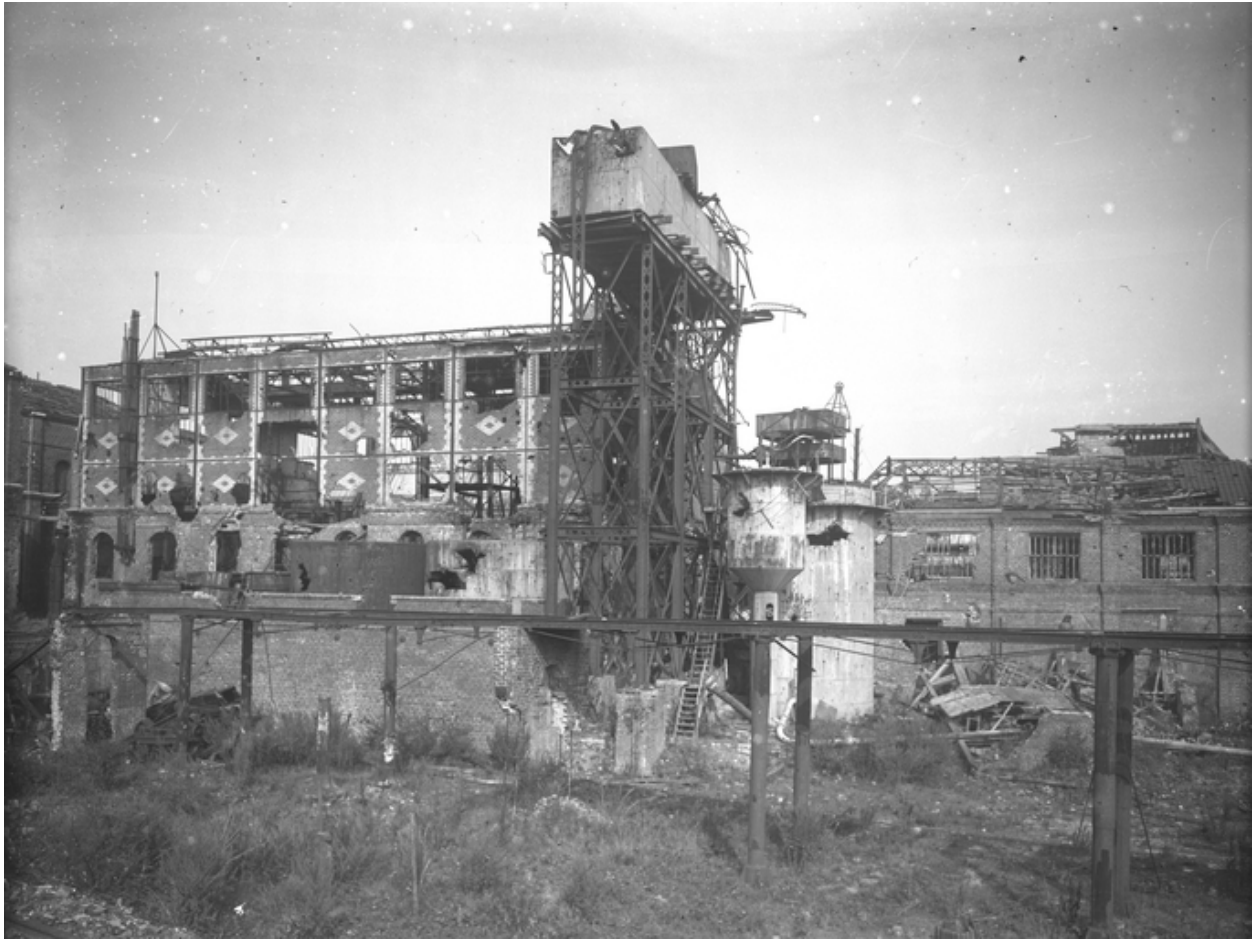
L'usine en ruine, 1919 (BM Saint-Quentin).
