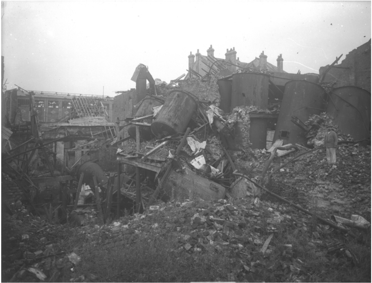
L'usine en ruine, 1919 (BM Saint-Quentin).
