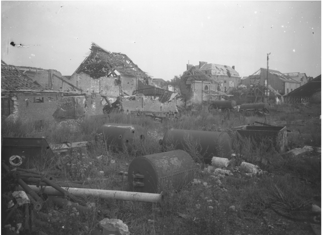
L'usine en ruine, 1919 (BM Saint-Quentin).
