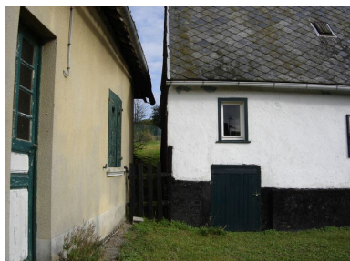
Vue du passage entre le logis et l'atelier donnant directement à la pâturée située à l'arrière de la propriété. Phot. Inès Guérin IVR22_20068005503NUCA
