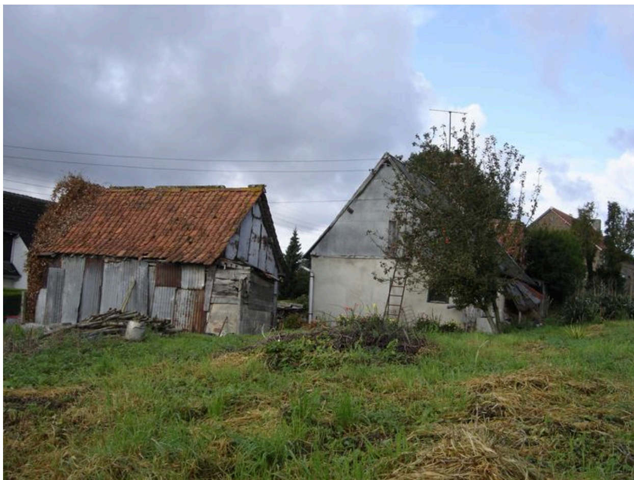
Vue générale postérieure depuis la pâture.
