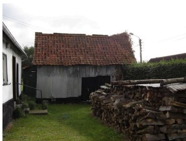
Vue de la grange. Phot. Inès Guérin IVR22_20068005504NUCA
