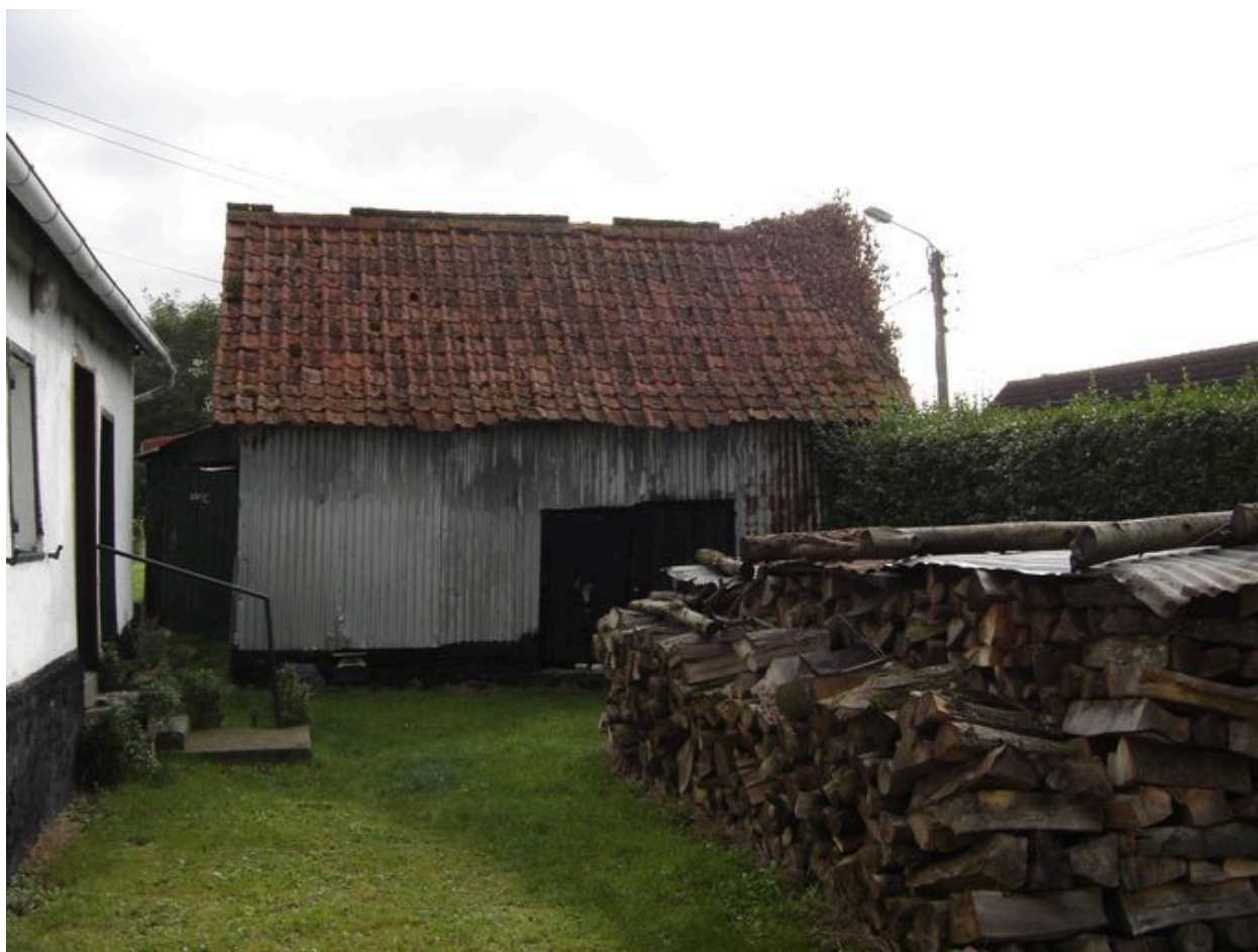
Vue de la grange.
