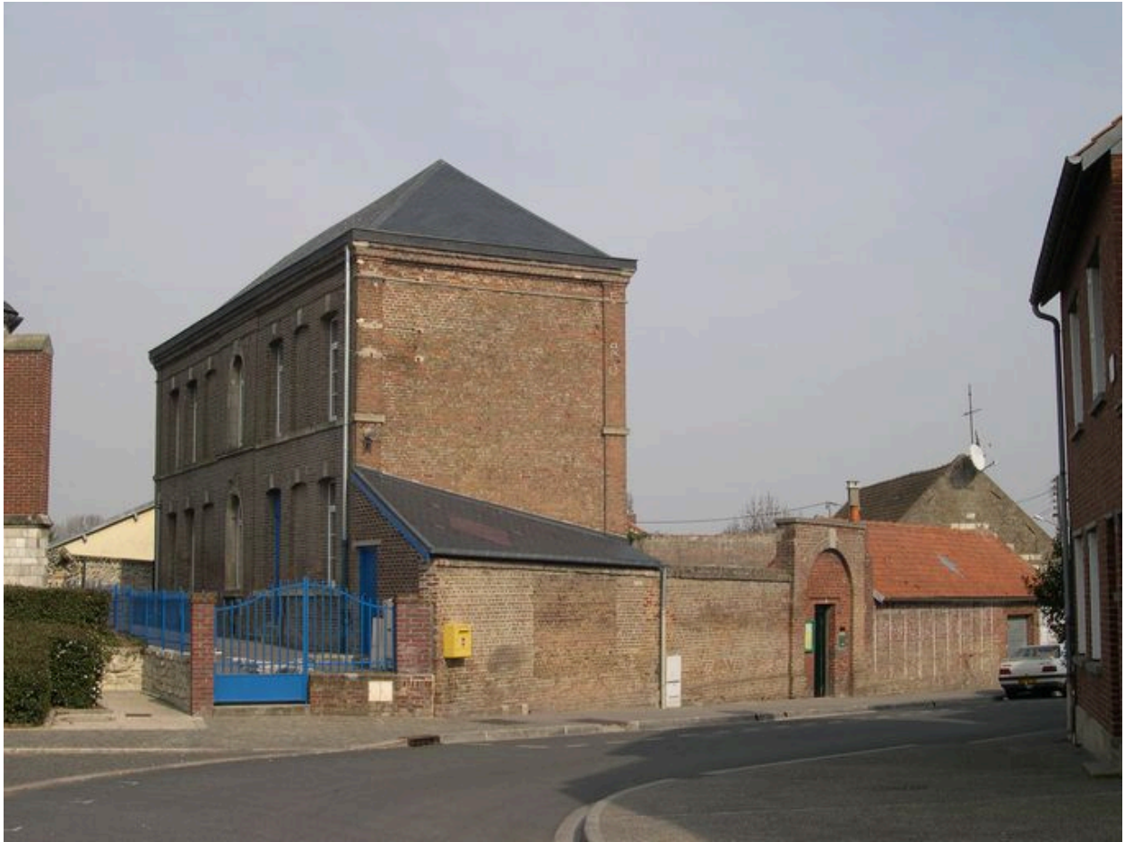
Le presbytère, vue depuis le sud.
