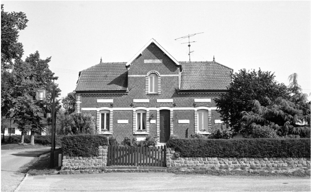
Façade antérieure, sur rue.
